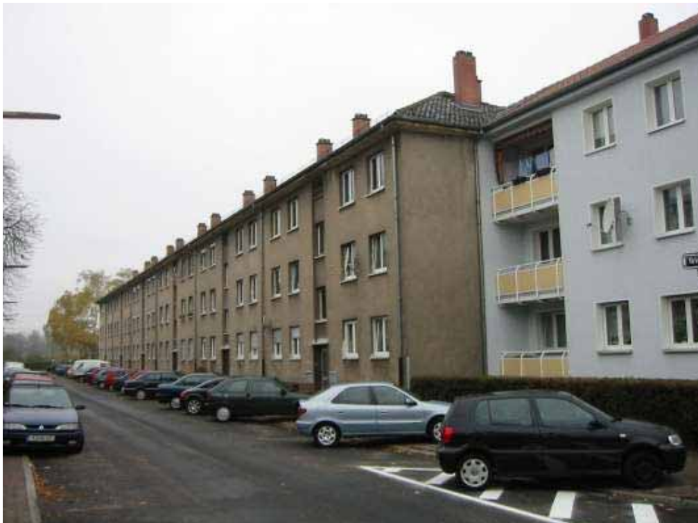
Obr 3: Před renovací - Projekt Tevesstrasse ve Frankfurtu (Německo). Roční spotřeba energie na vytápění 290 kWh/(m 2 a) dle výpočtu PHPP a spotřeba primární energie (pro vytápění, přípravu
