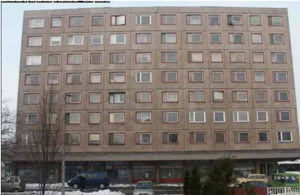
Před rekonstrukcí rok 2002.
