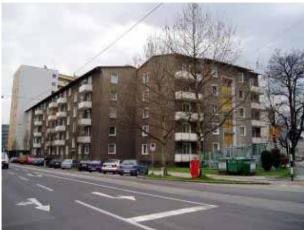
Původní stav před rekonstrukcí
