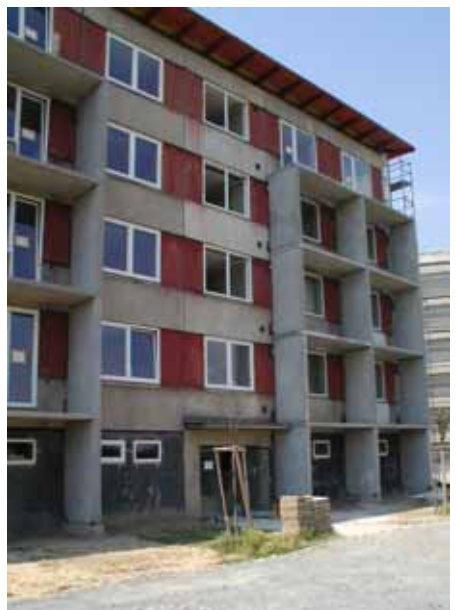
Izolované rozvody teplé vody a nově vybudované samonosné lodžie s minimalizací tepelných vazeb. Mezi lodžii a stěnou byl ponechán prostor 10 cm pro izolaci.
