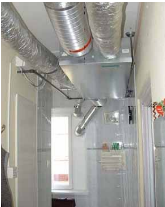
Větrací jednotka v pohledu chodby. Následně pak obložena sádrokartonem.
