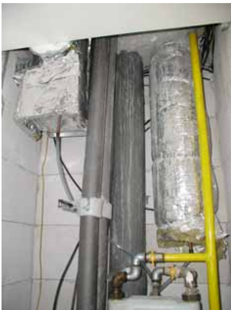
Izolované rozvody teplé vody a nově vybudované samonosné lodžie s minimalizací tepelných vazeb. Mezi lodžii a stěnou byl ponechán prostor 10 cm pro izolaci.
