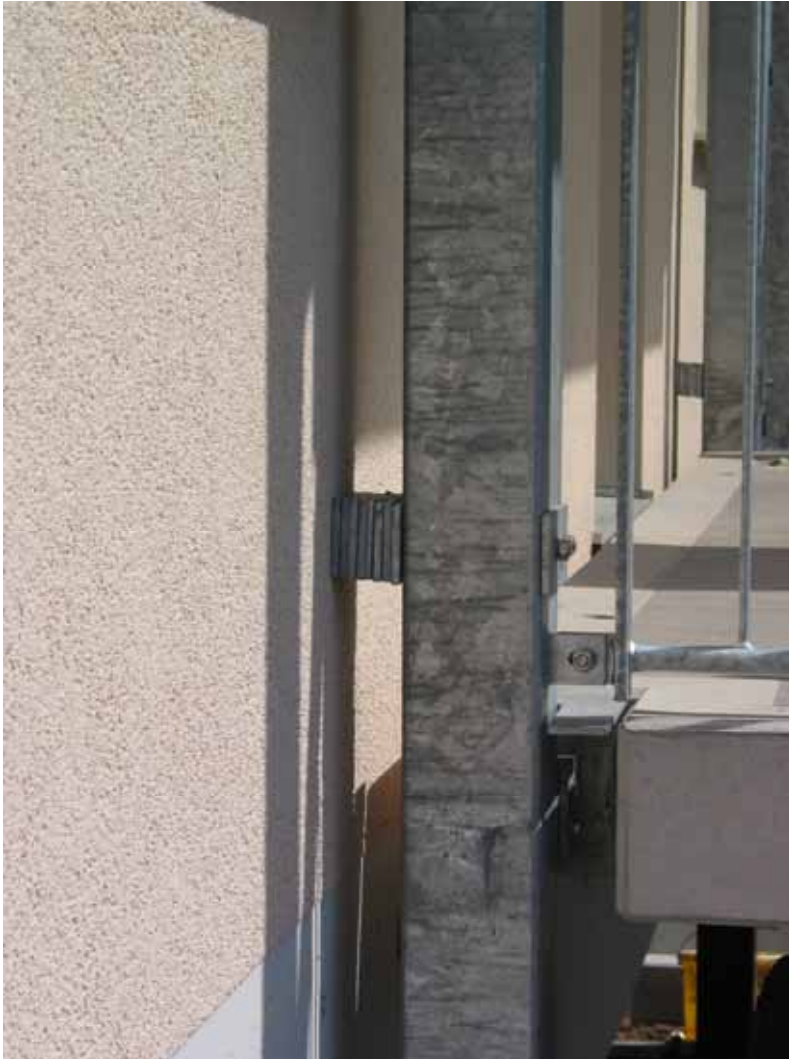
Bodové kotvení samonosné konstrukce balkónů.
