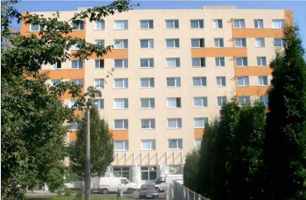
Po úspěšné rekonstrukci rok 2006.
