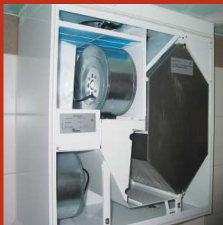
Obr. 7 O kvalitní vnitřní prostředí a neustálý přísun čerstvého vzduchu se stará větrací jednotka. Díky vysoce účinnému rekuperačnímu výměníku je vzduch ohříván na teplotu blízkou pokojové i v nejtužších mrazech. Dohřát je pak potřeba jen zbylých pár stupňů.
