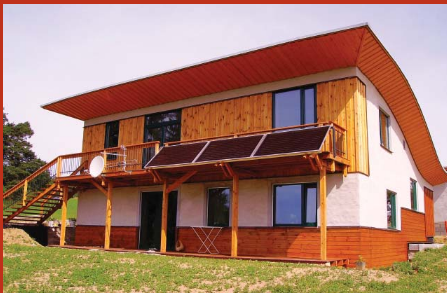
Obr. 1 Větší prosklení, tvar krychle, rovná střecha – to je nejčastější vzhled pasivních domů. Není to ovšem pravidlem. Pasivní domy lze stavět i na nepoznání od běžných domů, nebo také jako architektonicky zajímavé stavby. Většinou se však jedná o tvarově kompaktní stavby s jednoduchým řešením detailů. Autor návrhu: Aleš Brotánek
