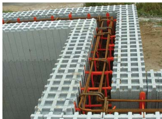
Obr. 5 Systémy ztraceného bednění lze také využít pro stavbu pasivních domů. Systémy zpravidla obsahují tvarovky pro rohy, překlady nebo i základy, což značně urychluje výstavbu.
