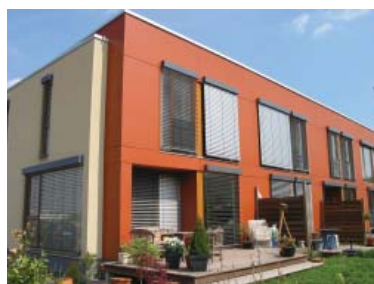
Obr. 4 Pasivní domy lze postavit s jakýmkoli typem střechy. Fakt, že většinou mají pultové nebo rovné střechy není jen záležitost stylu. Jednodušší detaily napojení, izolování, menší objem, plocha a také cena jsou hlavní důvody jejich volby.
