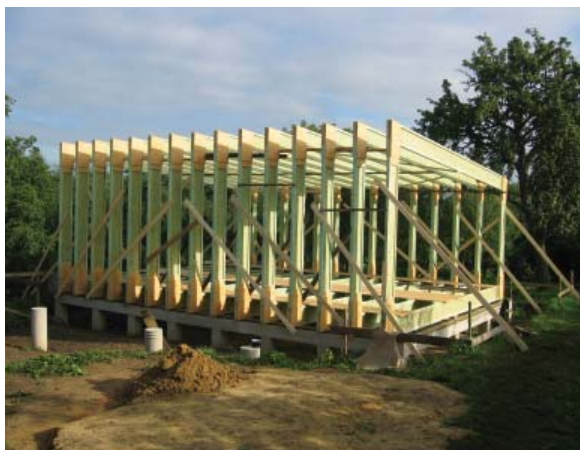
Obr. 6 Příklad dřevostavby s použitím I nosníků. Konstrukce je zevnitř zavětrována OSB deskou a izolace je vkládána do připraveného roštu. Výhodou takového řešení je jednoduchost a rychlost provedení.
