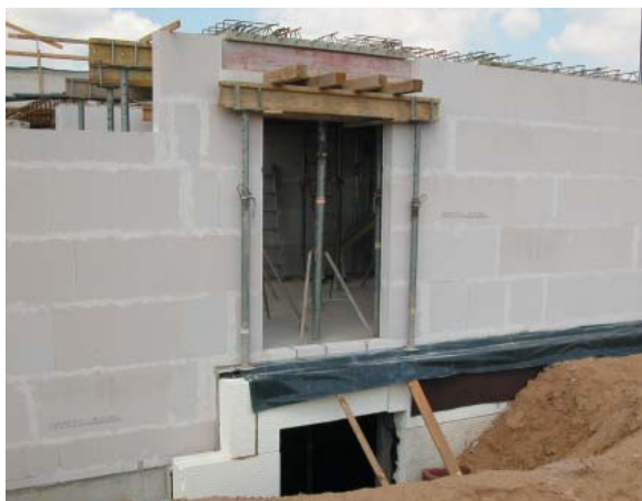
Obr. 7 Masivní konstrukce z vápenopískových cihel je pro pasivní domy ideální. Velká objemová hmotnost zabezpečuje vysokou únosnost, výborné akustické vlastnosti a akumulaci schopnost při malé tloušťce stěn. Současně se jedná o materiál s velmi nízkou spotřebou primární energie při výrobě. Větší vápenopískové bloky umožňují rychlé mechanizované zdění pomocí minijebu. Zateplování se pak realizuje běžnými kontaktními systémy.
