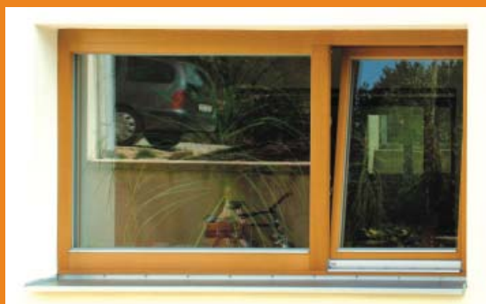
Obr. 9 Okno s otvíravou a neotvíravou částí a s vyrovnáním skel na stejnou výšku
