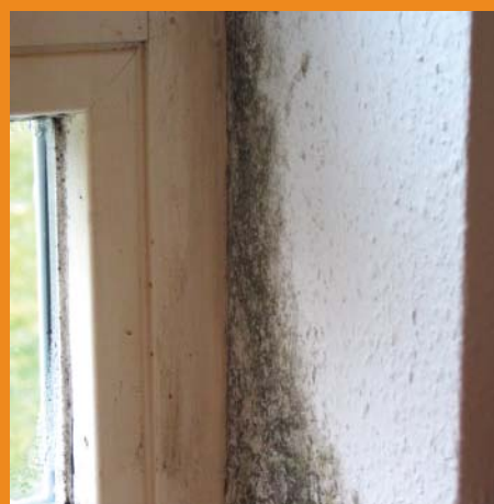
Obr. 8 Při nedostatečném utěsnění připojovací spáry okna dochází ke zvýšenému tepelnému a vlhkostnímu toku. Při spojení s nedostatečným větráním je potom výsledkem plesnivění ostění, parapetů a rámu oken. Tím dochází k mnohem rychlejší degradaci materiálů.
