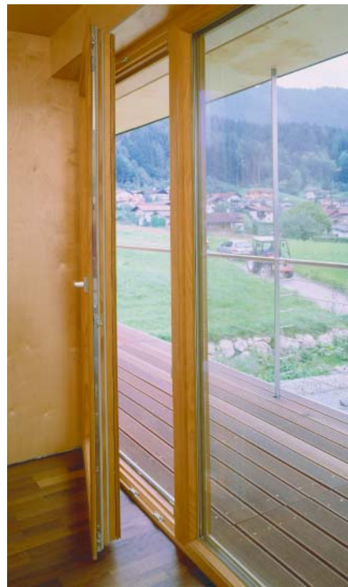
Obr. 10 Většina architektů navrhuje velké prosklené plochy obytných místností zejména kvůli vizuálnímu kontaktu s přírodou nebo okolím. Ty zabezpečují dostatek slunečních zisků, ale v letním období mohou způsobovat značné přehřívání interiéru. Vyvážené množství prosklených ploch s případným letním stíněním je proto pro pasivní domy zásadní.
