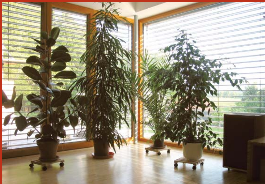
Obr. 1 Velké prosklené plochy působí bezpochyby efektně. Jsou však zdrojem značných solárních zisků a vyhnout se přehřívání lze jen použitím nákladných vnějších stínících prvků.
