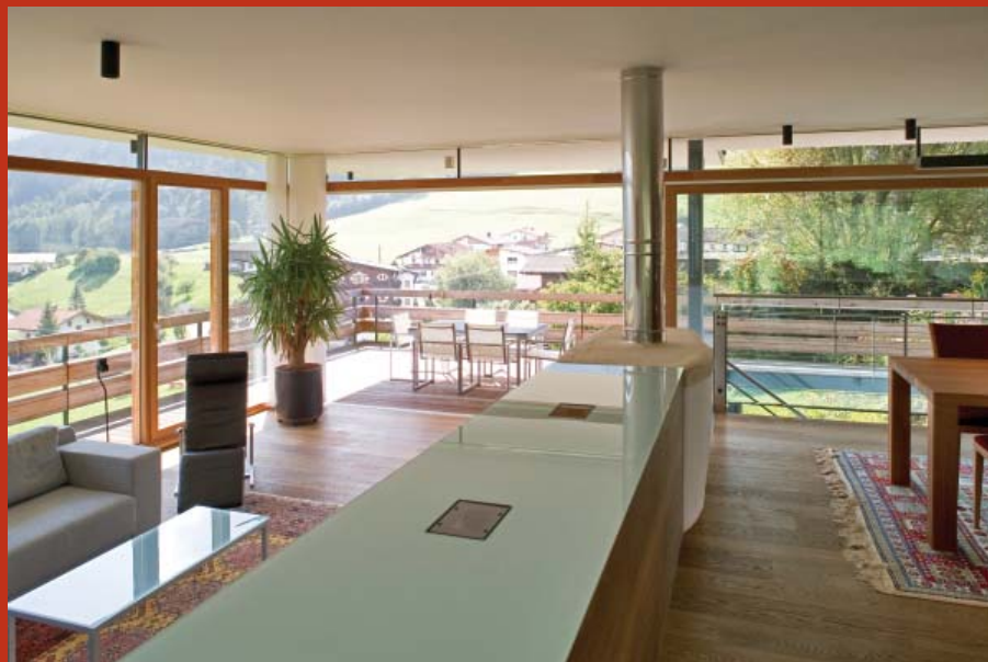
Obr. 1 Bohaté prosklení obytných místností může působit velmi efektně, ale musí být navrhováno s mírou. Skleněné plochy totiž způsobují velké tepelné ztráty v zimě a zároveň přehřívání interiéru v létě. Samozřejmostí by měl být promyšlený systém stínění, který je u větších ploch finančně nákladný.
