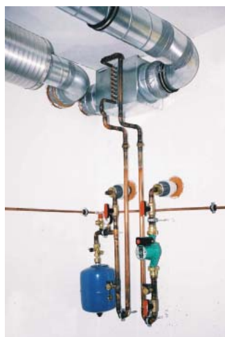
Obr. 14 Schéma a zapojení kapalinového zemního výměníku tepla.
