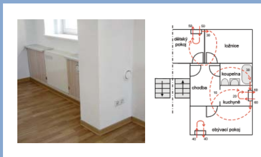
Obr. 9 Efektivní větrání prostor lze zabezpečit i malými nástěnnými jednotkami. Zvláště výhodné pro větrání malých prostor nebo rekonstruovaných objektů. Umístění jednotky je zde řešeno jednoduchým způsobem s malými nároky na prostor a s minimálním počtem a délkou rozvodů.
