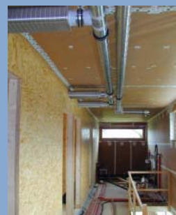
Obr. 12 Rozvody v podlaze a pod stropem. Důležité nezapomenout na revizní otvor.
