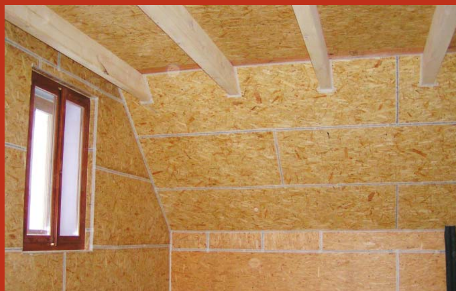
Obr. 2 Neprůvzdušnost zajišťuje spojitá vzduchotěsná vrstva, která musí být precizně vyhotovena. Veškeré napojení konstrukcí a stavební otvory jsou utěsněny speciálními páskami. Kromě tepelných ztrát tato vrstva chrání konstrukce před vlivem vlhkosti, která se šíří přes netěsnosti.
