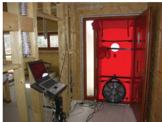
Obr. 11 Měření neprůvzdušnosti je nezbytnou součástí realizace a zajištění kvality pasivních domů. Po dokončení vzduchotěsnicí vrstvy je nutné provést měření, aby odhalené netěsnosti mohly být včas opraveny.
