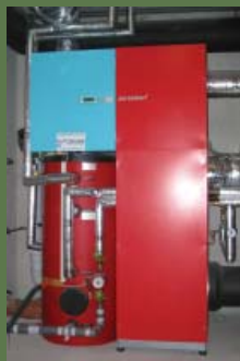
Obr. 3 Kompaktní jednotka velice efektivně využívá spojení větrací jednotky a miniaturního tepelného čerpadla, které využívá odpadní vzduch z rekuperačního výměníku. Vyrobené teplo lze využít jak pro vytápění, tak pro ohřev teplé vody. Vhodným doplňkem jsou solární kolektory nebo fotovoltaika.
