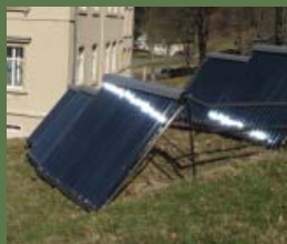
Obr. 4 Vakuové trubkové kolektory se vyznačují velkými výkony i při různém sklonu a natočení. Zejména v přechodném období zabezpečují oproti plochým kolektorům větší zisky.
