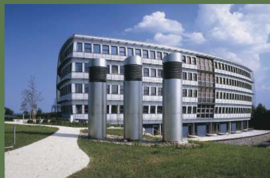
Obr. 6 Administrativní budova v Německu, je ukázkou, že v pasivních standardech lze stavět i velké objekty. Přepřpracovaný systém topení a chlazení zde využívá geotermální energii z vrtů. Teplonosná látka proudí betonovými stropy, které slouží jako akumulátory tepla nebo chladu, s jejich postupným a rovnoměrným výdajem.
