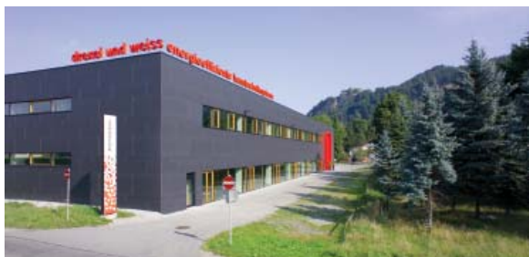
Obr. 14 Ukázka, že „zpasivnit“ lze všechny druhy budov, výrobní haly nevynímaje. Nahoře před rekonstrukcí, dole po rekonstrukci.
