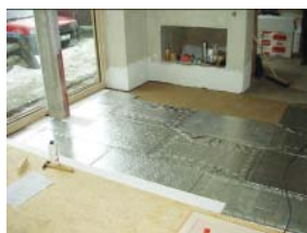
Obr. 4 Vakuová izolace i v malé tloušťce 3–4 cm dokáže zabezpečit dostatečné tepelně izolační vlastnosti jako 20–30 cm polystyrenu. Lze ji použít prakticky všude, zejména však pro složité detaily s těžko izolovatelnými místy, třeba izolování ostění – obrázek vpravo.
