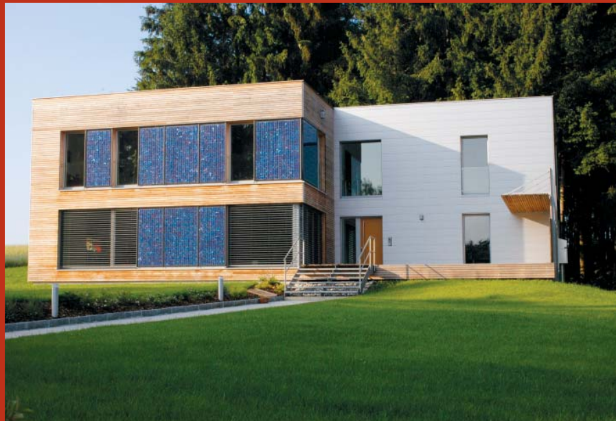
Obr. 1 Podobně jako rodinný dům se dá zrekonstruovat na úroveň pasivního standardu většina budov. Na obrázku zrekonstruovaný dům v Rakousku.
