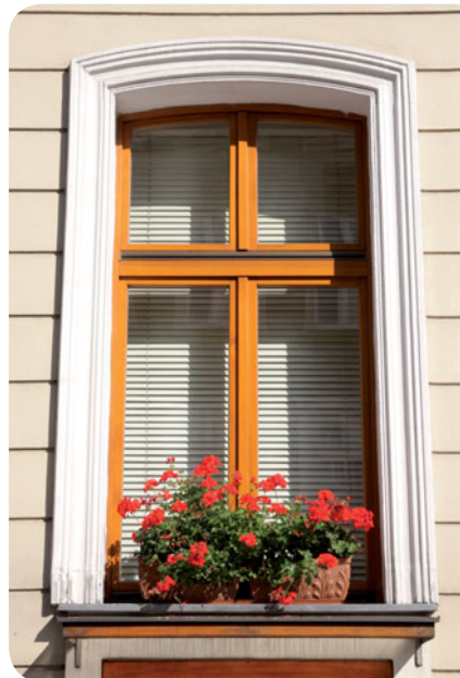
Zdařilá výměna oken v historické městské zástavbě
