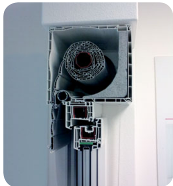
Řez okenním systémem s vnější roletou
