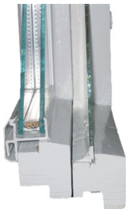
Detail výměny vnějšího zasklení za PVC profil s dvojsklem (nevýhoda: přetížení celého křídla, které pak může poškodit původní kování)
