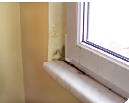
Vznik plísní při zatečení
