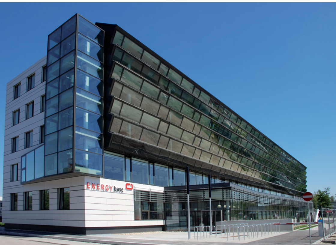
Detail stínění s použitím fotovoltaických panelů (foto nahoře)
