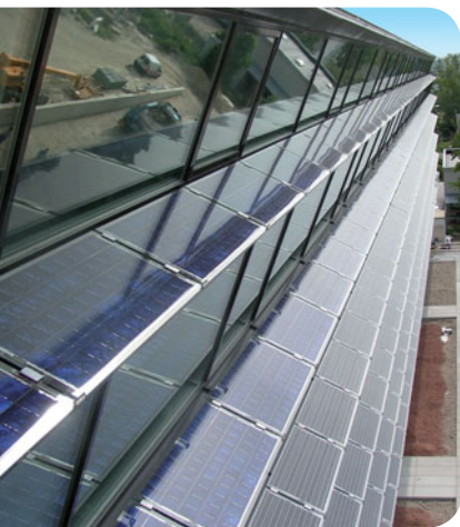
Detail stínění s použitím fotovoltaických panelů (foto nahoře)
