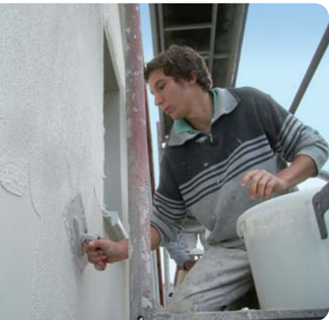
UdiPERL – nanášení krycí vrstvy na vyschlou stěrku a vytváření struktury
