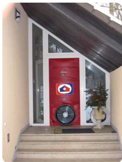
Blower Door test – exteriér
