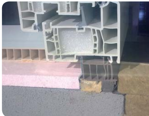
Příklad správného řešení detailu zateplení otvorové výplně
