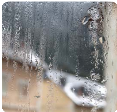
Kondenzace vodních par na okně
