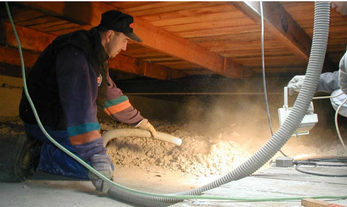
Aplikace foukané izolace Climatizer Plus
