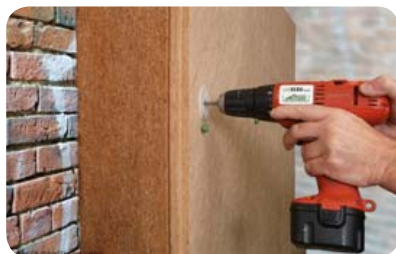
Instalace dřevovláknitých desek UdiilN RECO
