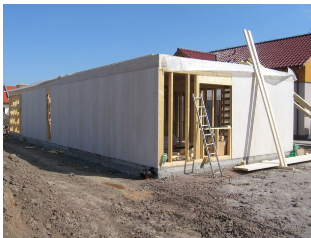
Obr. 72 - Montáž opláštění ze sádrovláknitých desek
