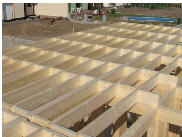
Obr. 59 - Rozpěry vložené mezi stropní nosníky
