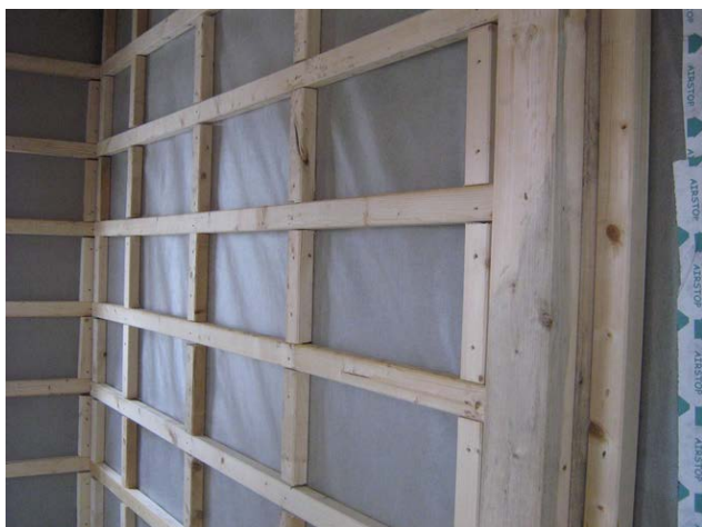
Obr. 76 - Vnitřní obousměrný rošt
