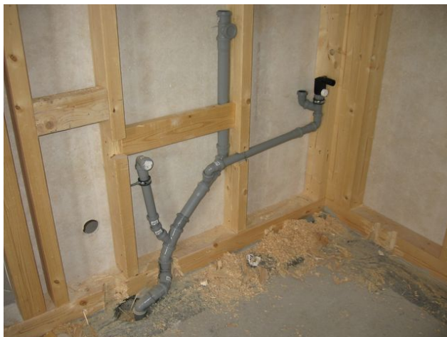
Obr. 85 - Rozvod kanalizace uvnitř nosné obvodové stěny
