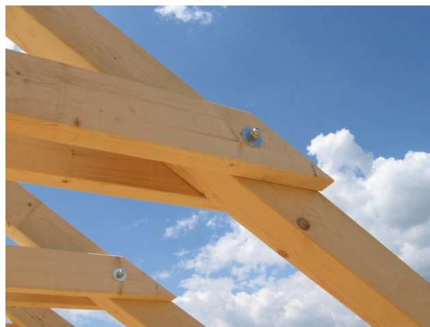
Obr. 69 - Kleštiny kotvené ocelovými svorníky na krokve
