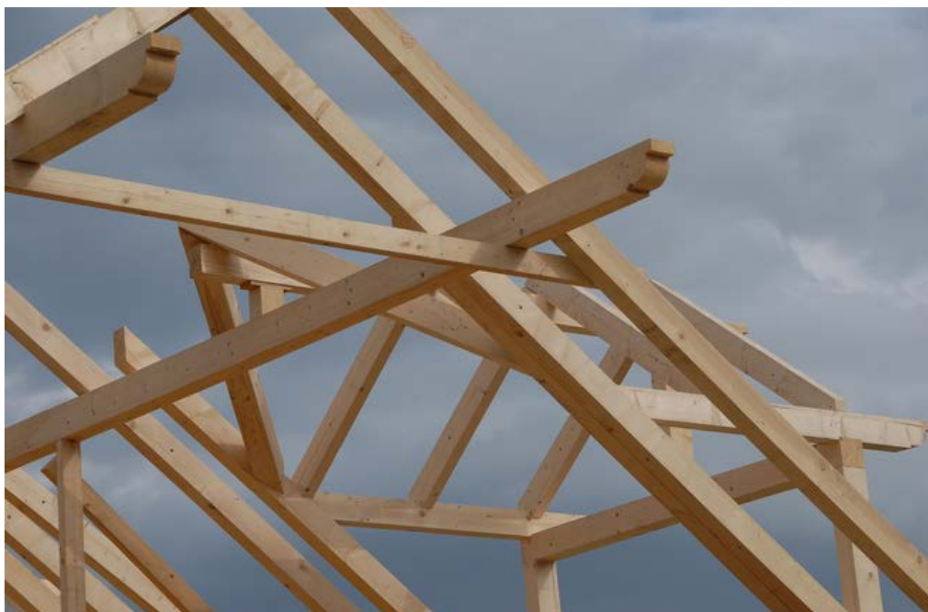
Obr. 65 - Krov z prvků s předem vyřezanými spoji
