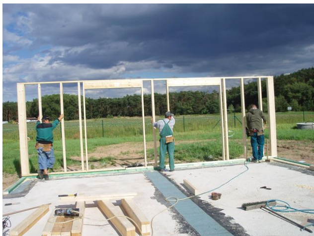
Obr. 35 - Vztyčení rámu stěny
