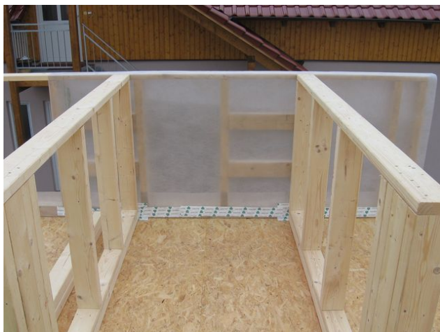
Obr. 63 - Montáž vnitřních stěn 2.NP
