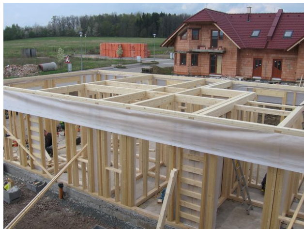
Obr. 53 - Přířezy parotěsnicí fólie na horních rámových hranolcích a provedené věncové hranolky
