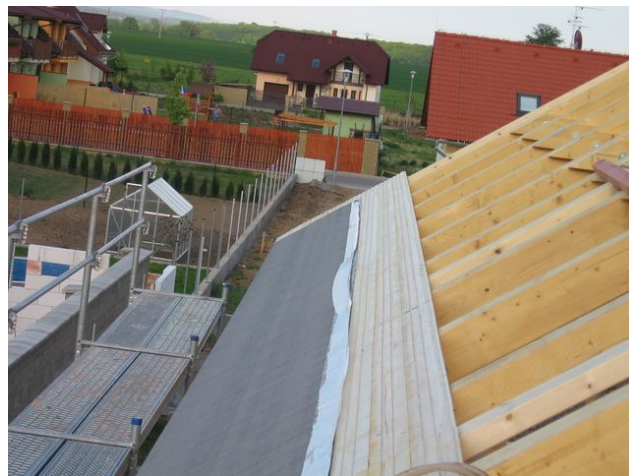
Obr. 82 - Montáž záklopu z palubek a parozábrany ze samolepicího asfaltového pásu
