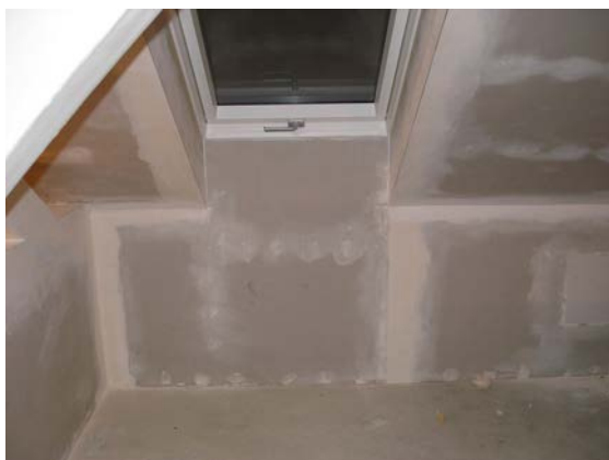
Obr. 107 - Civilní snímek parapetu střešního okna
