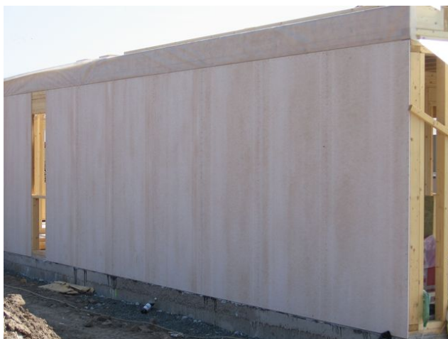
Obr. 71 - Montáž opláštění ze sádrovláknitých desek
