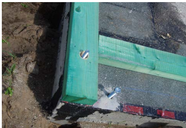
Obr. 30 - Fotografie kotvení základového prahu
