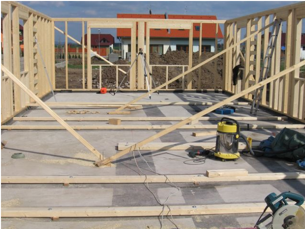
Obr. 48 - Základové prahy pro vnitřní stěny
