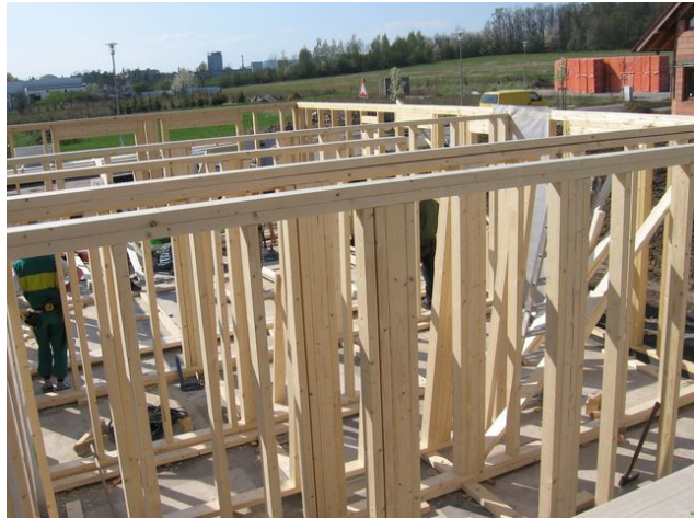
Obr. 49 - Provedené vnitřní nosné stěny se skrytými sloupy
