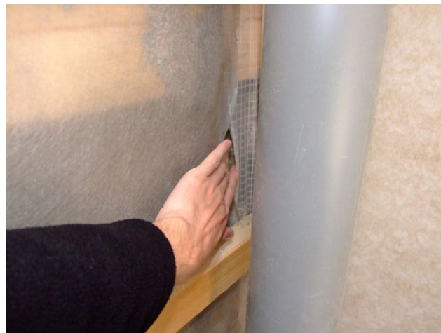
Obr. 114 - Jedna z nalezených netěsností
