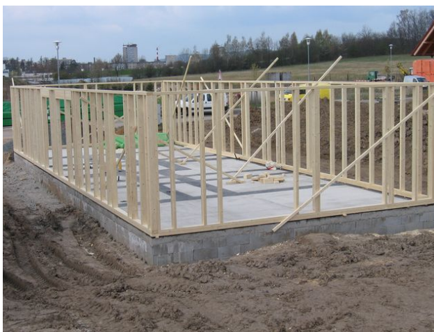
Obr. 41 - Pohled na vztyčené a zavětrované rámy obvodových stěn
