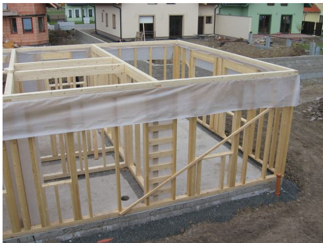
Obr. 52 - Přířezy parotěsnicí fólie na horních rámových hranolcích a provedené věncové hranolky
