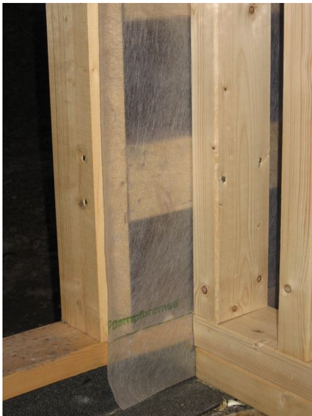
Obr. 46 - Fólie AIRSTOP v místě návaznosti vnitřní na vnější stěnu
