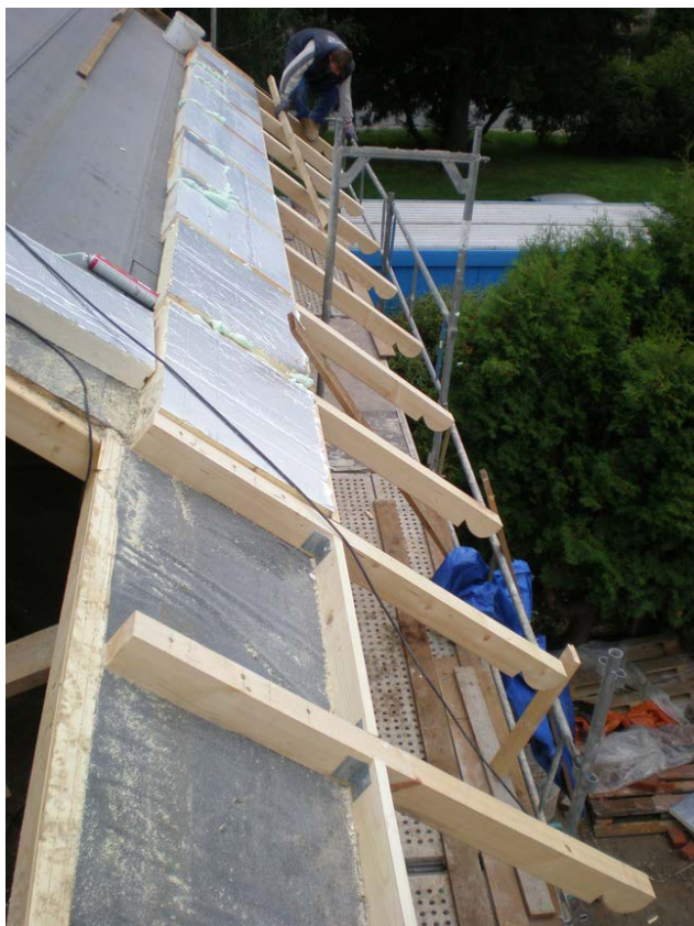
Obr. 83 - Námětky u okapu, provádění tepelné izolace z PIR panelů
