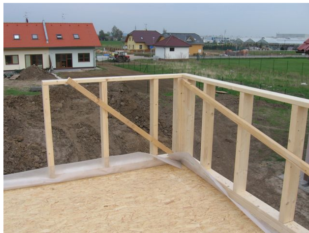
Obr. 62 - Montáž rámu stěn 2.NP
