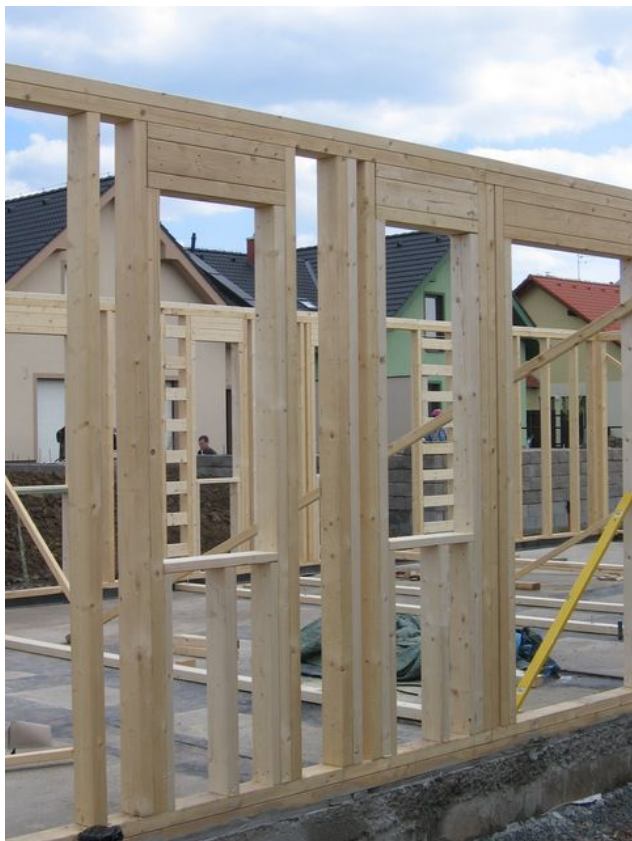
Obr. 44 - Překlady nad otvory
