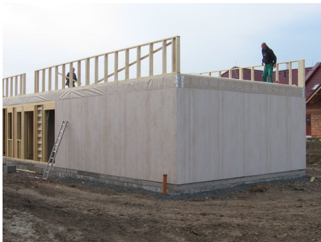
Obr. 61 - Montáž rámu stěn 2.NP
