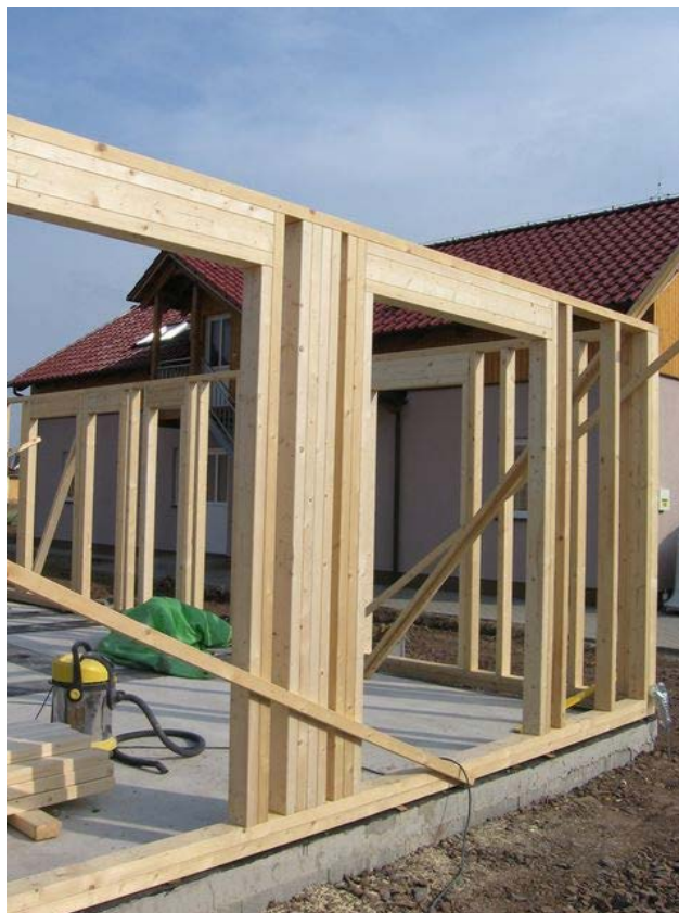
Obr. 45 - Překlady nad otvory
