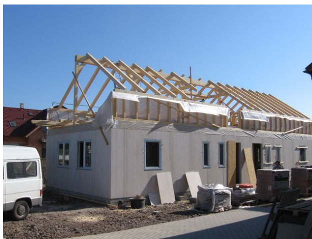
Obr. 67 - Krokve osazené na střední vaznici a pozednicové stěny
