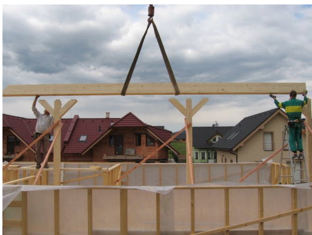
Obr. 66 - Osazování střední vaznice na nosné sloupky ve 2.NP
