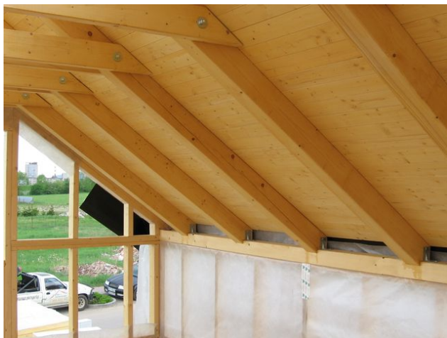
Obr. 81 - Záklop z dřevěných palubek
