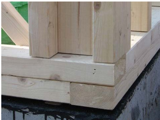
Obr. 38 - Detail napojení dvou obvodových stěn
