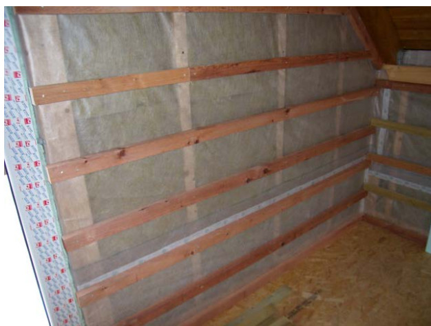
Obr. 77 - Vnitřní obousměrný rošt
