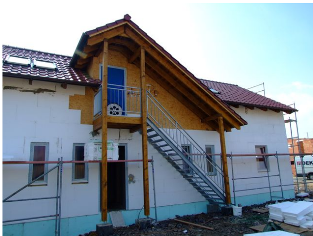
Obr. 113 - Osazené testovací zařízení
