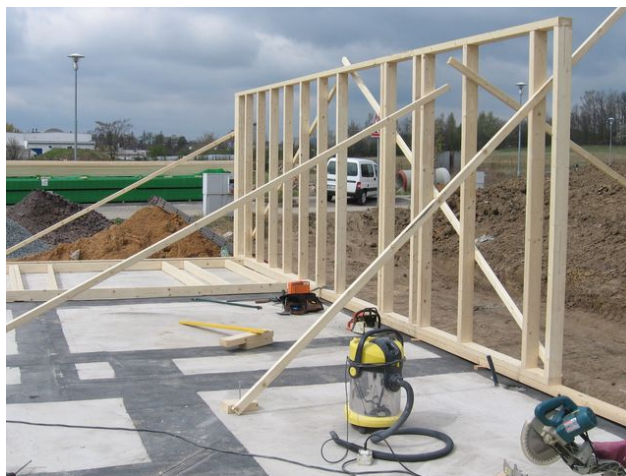
Obr. 36 - Provizorní zajištění rámu stěny
