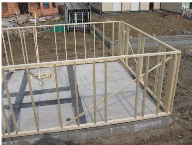
Obr. 40 - Pohled na vztyčené a zavětrované rámy obvodových stěn
