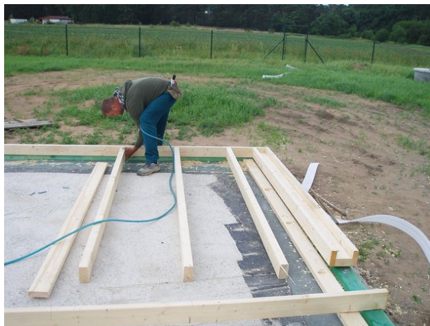
Obr. 34 - Spojování hřebíky
