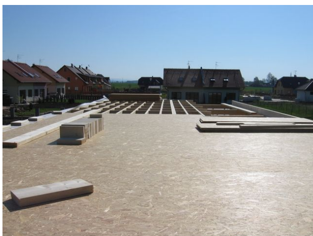
Obr. 58 - Provádění záklopu z OSB desek
