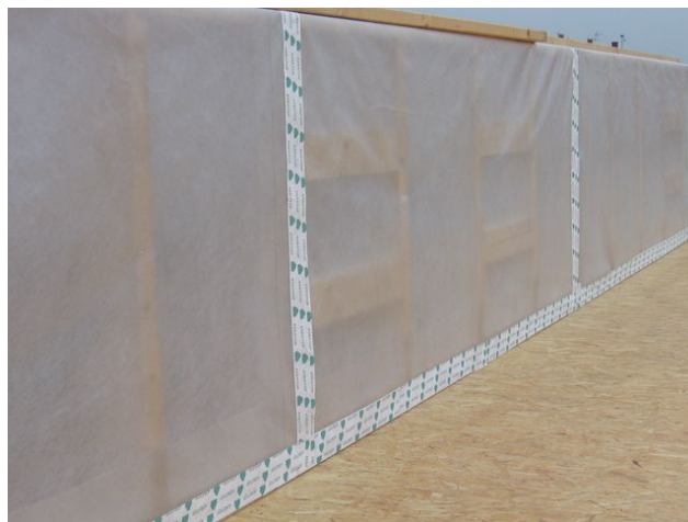
Obr. 64 - Montáž parozábrany ve 2.NP
