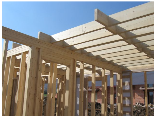
Obr. 57 - Rozpěry vložené mezi stropní nosníky
