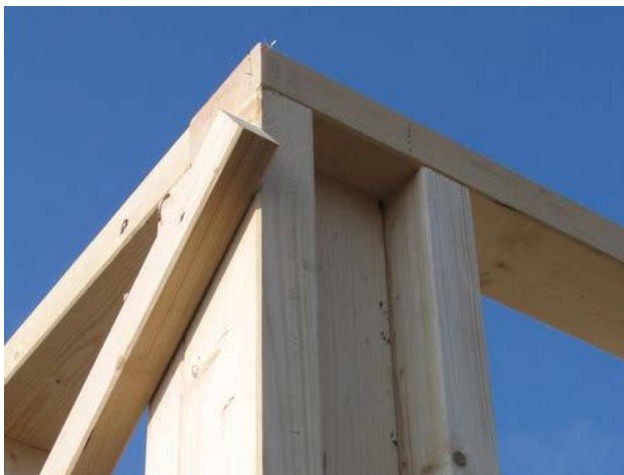
Obr. 39 - Detail napojení dvou obvodových stěn
