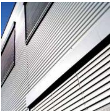
Obr. 47 - Trapézový profil orientovaný vodorovně
