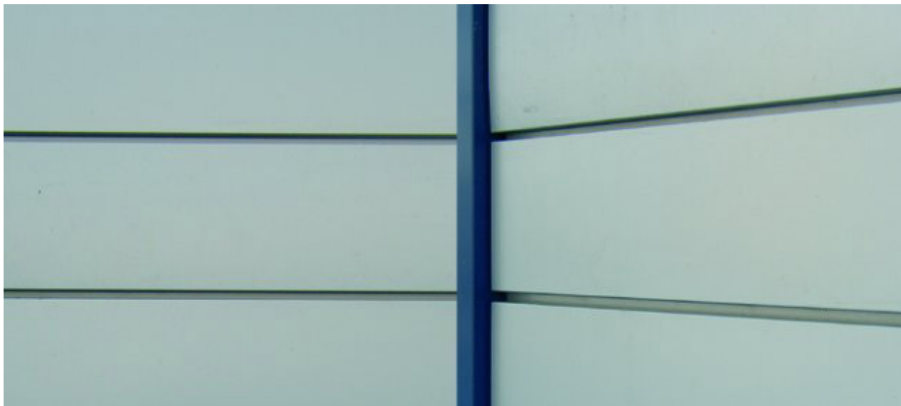
Obr. 46 - Detail spáry DEKLAMELLA
