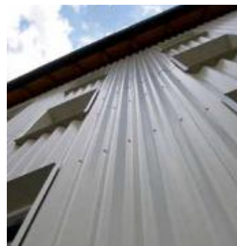
Obr. 48 - Trapézový profil orientovaný svisle
