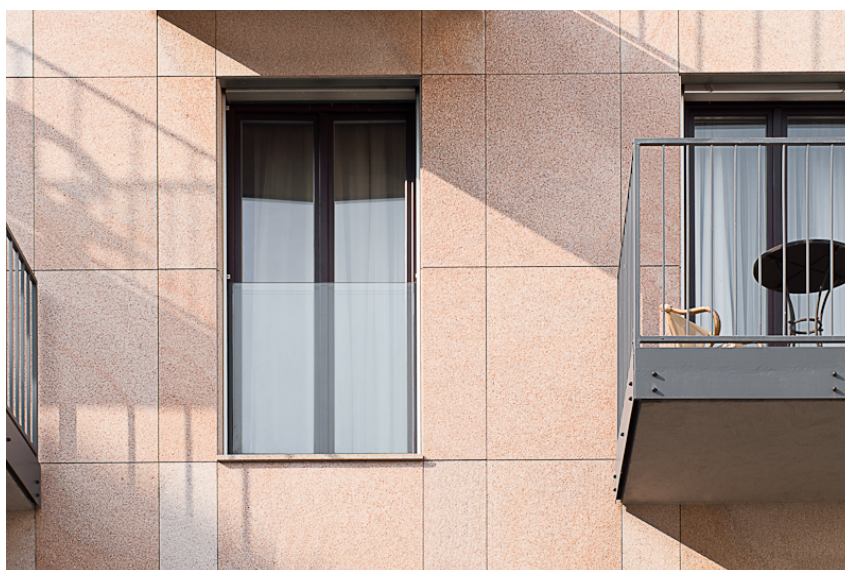
Obr. 54 - Jeden z možných vzhledů provětrávané fasády s kamenným obkladem
