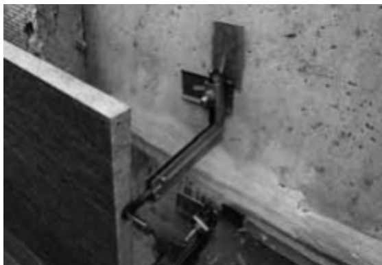
Obr. 51 - Bodové kotevní prvky s trny
