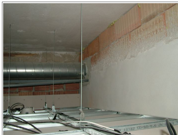
Obr. 22 - Pohled do prostoru nad kazetovým stropním podhledem – neomítnuté zdivo stěny
