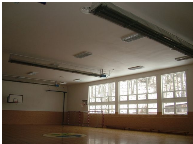
Obr. 24 - Interiér školní tělocvičny bez zvukopohltivých úprav
