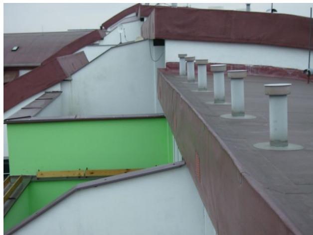
foto /116/ Odvětrávací komínky vzduchové mezery
