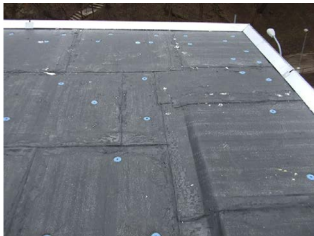
foto /104/ Pohled na střechu s položenými dílci POLYDEK
