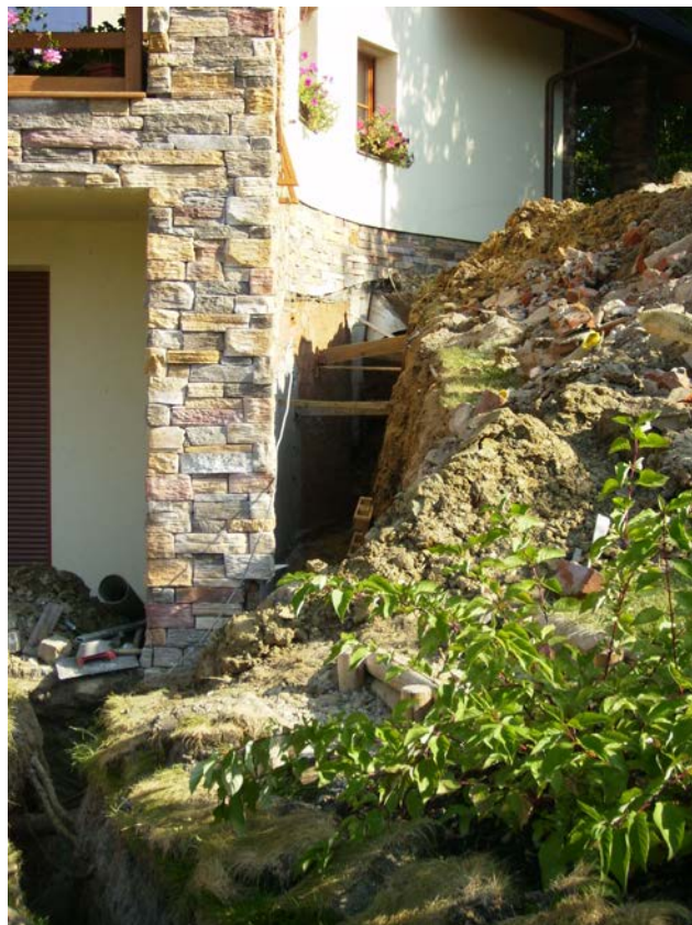
foto /7/ Odkop terénu na východní straně objektu
