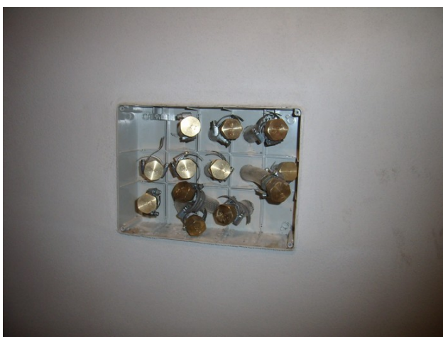
foto /31/ Vyústění kontrolních hadic v krabici po provedení vnitřních omítek
