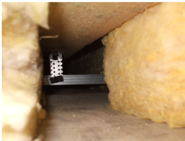
foto /189/ Pohled dovnitř sondy
