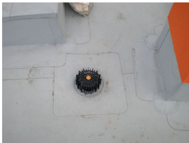
foto /83/ Střešní vtok s ochranným košem
