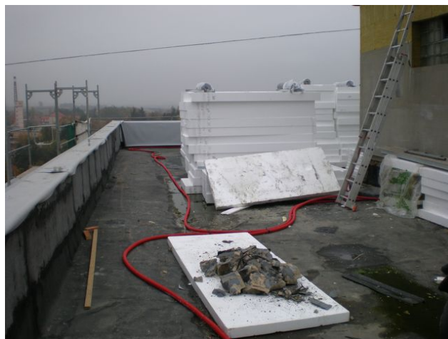
foto /47/ Opravená původní hydroizolace sloužící v nové skladbě jako parozábrana; naskladněná tepelná izolace z EPS; provedení vytažení parozábrany na atiku
