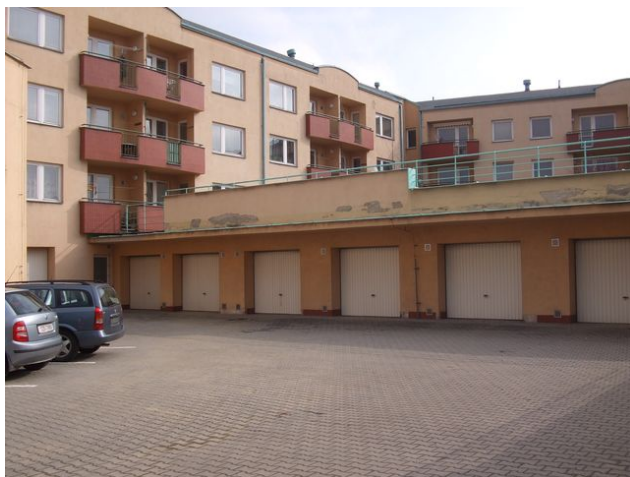
foto /54/ Pohled na objekt ze strany vjezdů do garáží
