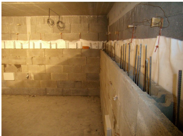
foto /28/ Provádění železobetonové stěny ze ztraceného bednění s vkládanou výztuží
