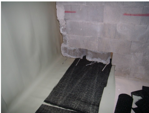
foto /21/ Pohled na podbouranou část vnitřní suterénní zdi
