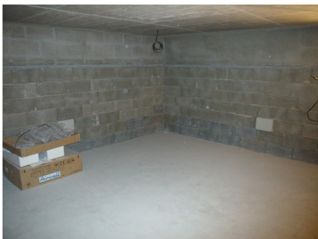
foto /30/ Pohled na dokončené vnitřní stěny před provedením vnitřním omítek
