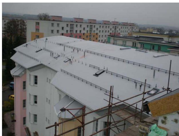
foto /132/ Pohled na hotovou část střechy
