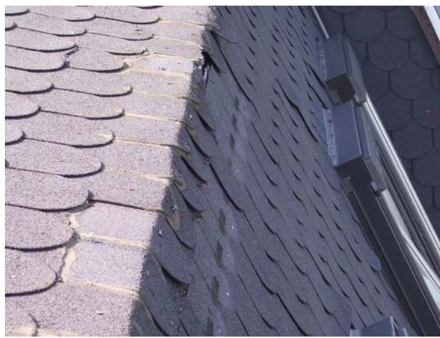
foto /148/ Degradace asfaltových šindelů v místě mansardové hrany
