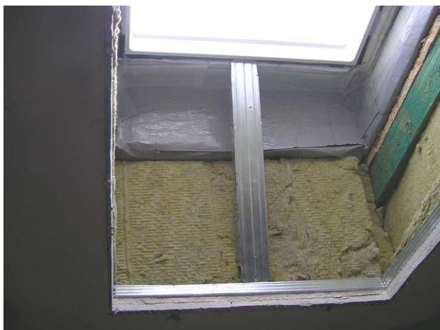
foto /133/ Detail opravy parozábrany ze samolepícího asfaltového pásu okolo střešního okna
