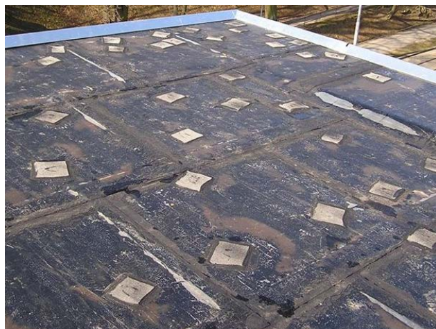
foto /106/ Kotevní prvky převařené přířezy z asfaltových pásů
