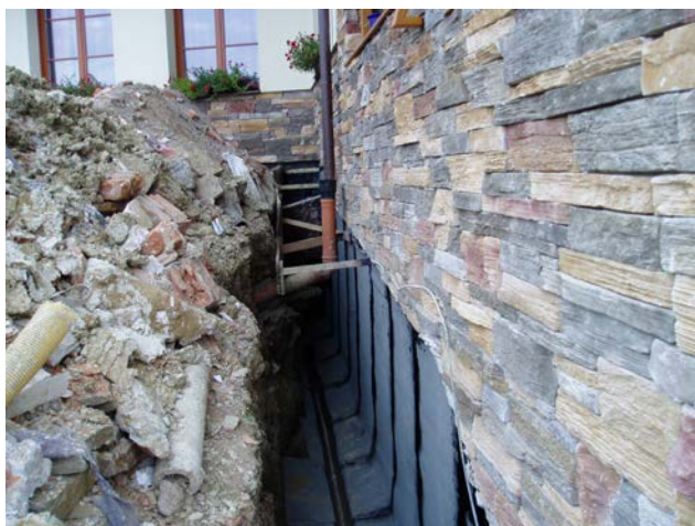
foto /8/ Provedená podkladní betonová mazanina se žlábkem, natavená hydroizolace z asfaltového pásu GLASTEK 40 SPECIAL MINERAL
