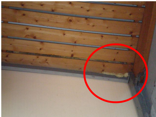
foto /180/ Foto realizace neúplných opatření projektového návrhu – vyplnění netěsností PUR pěnou
