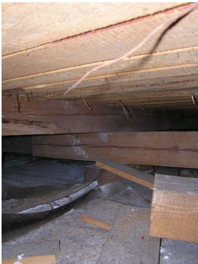
foto /76/ Pohled do větrané vzduchové vrstvy
