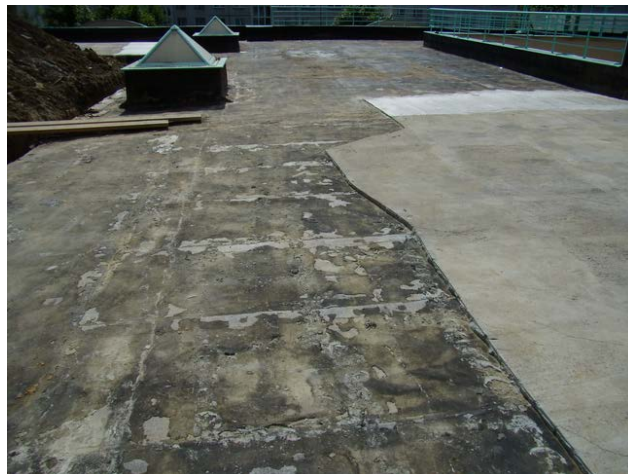
foto /61/ Původní hydroizolační souvrství po demontáži vegetační vrstvy
