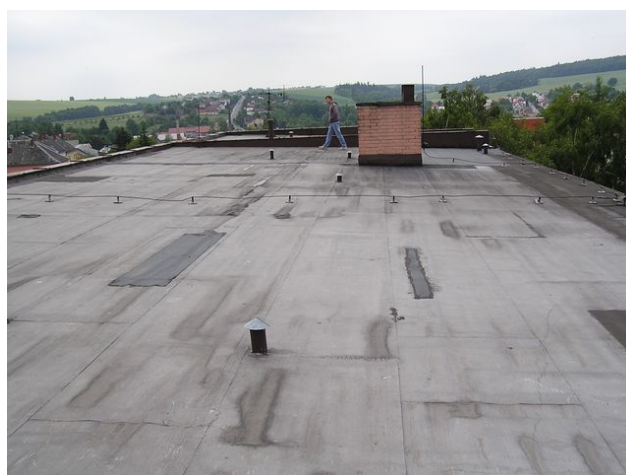
foto /75/ Pohled na finální povrch provozní střechy
