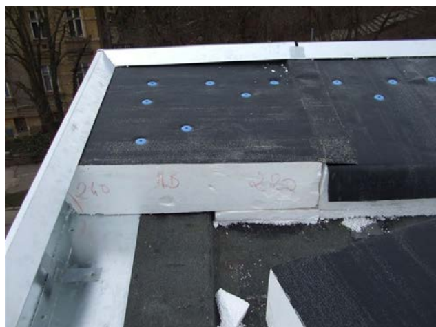
foto /101/ Kladení a kotvení kompletizovaných tepelněizolačních dílců z EPS s nakaširovaných asfaltovým pásem (POLYDEK); okraj střechy řešen klempířskou konstrukcí (UNIDEK); kotvení pomocí šroubů do betonu s plastovým teleskopem
