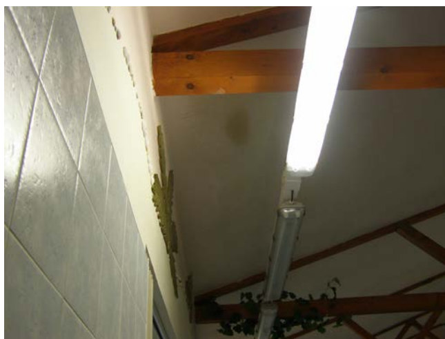
foto /207/ Reálné foto detailu v interiéru
