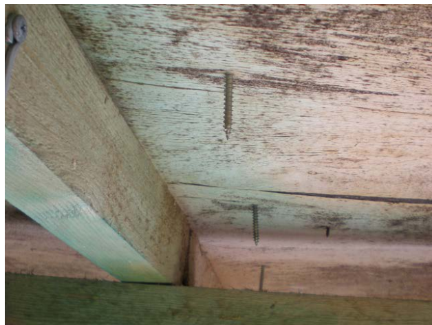
foto /118/ Plíseň na spodním povrchu zákopu
