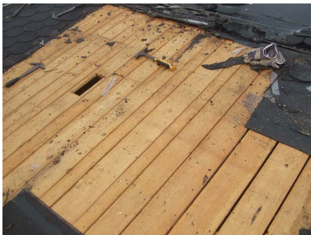
foto /149/ Demontáž krytiny z asfaltových šindelů
