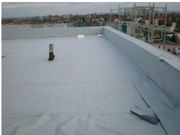
foto /52/ Rozpracovaný detail hydroizolace atiky
