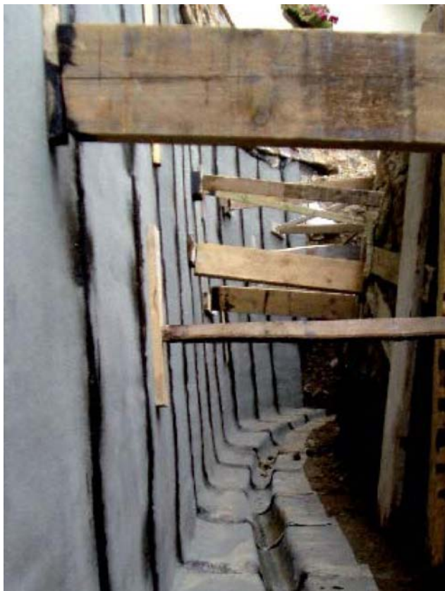
foto /10/ Provedena svislá hydroizolace s napojením na betonovou podkladní mazaninu s vytvořeným žlábkem ve spádu 0,5% pro uložení drenážní hadice
