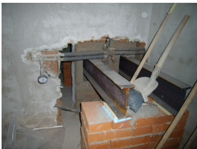
foto /22/ Pracovní vynesení komínové konstrukce
