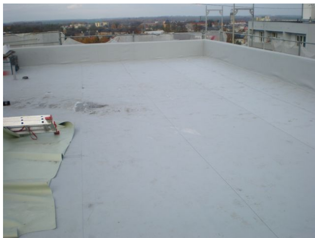
foto /53/ Pohled na hotovou část střechy
