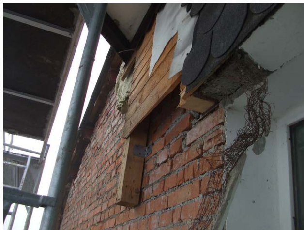
foto /150/ Demontáž obložení stěn mansardy
