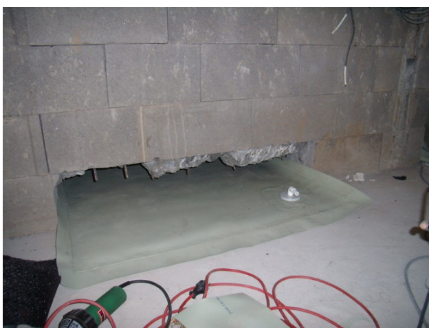
foto /23/ Pohled na podbouranou část vnitřní suterénní zdi
