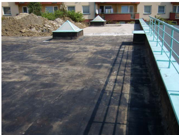
foto /62/ Natavení asfaltového pásu DEKGLASS na původní hydroizolaci
