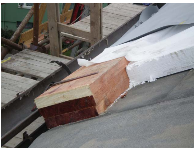
foto /128/ Pohled na provedení detailu u okapu (kotvení háků podokapních žlabů)
