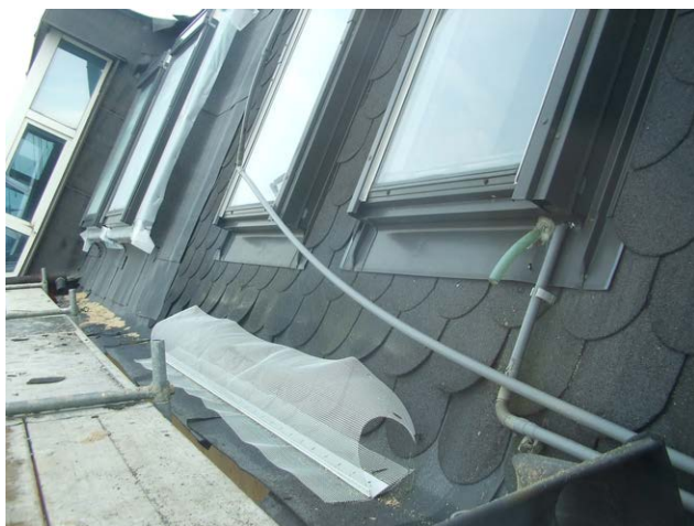
foto /151/ V popředí stávající okna, v pozadí nová střešní okna
