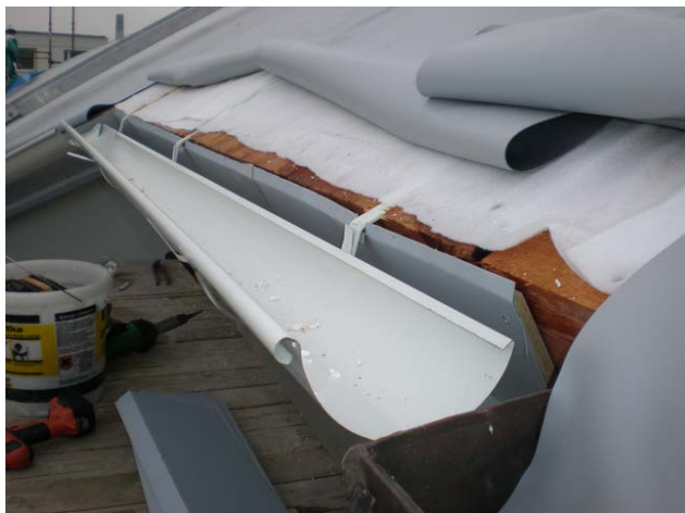
foto /129/ Pohled na provedení detailu u okapu (kotvení háků podokapních žlabů)
