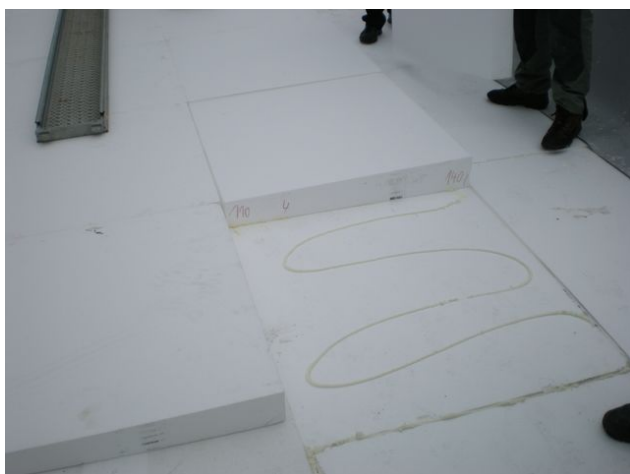
foto /48/ Provádění nové tepelněizolační a spádové vrstvy ze spádových klínů z EPS – zde první vrstva z rovných desek, druhá vrstva ze spádových klínů (vrstvy mezi sebou lepeny polyuretanovým lepidlem)
