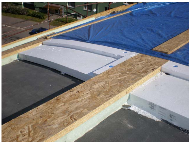
foto /125/ Pokládka a kotvení tepelné izolace; prahy pro kotvení sněhových zachytávačů z OSB desek ve dvou vrstvách na tepelné izolaci z extrudovaného polystyrenu
