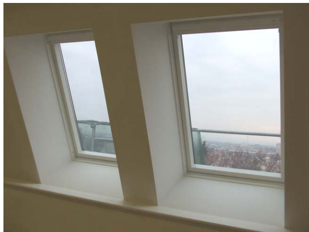
foto /158/ Pohled na nová střešní okna
