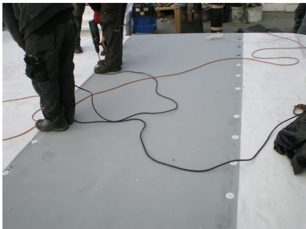
foto /50/ Provádění nové hydroizolace ze střešní PVC-P fólie DEKPLAN 76 se separační netkanou textilií FILTEK 300; kotvení hydroizolace
