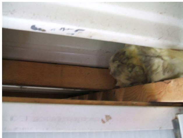
foto /174/ Výplň přířezy minerální vlny
