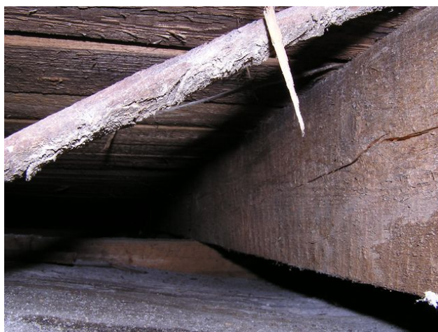
foto /79/ Pohled do větrané vzduchové vrstvy s viditelnou nosnou konstrukcí horního pláště z dřevěných trámů
