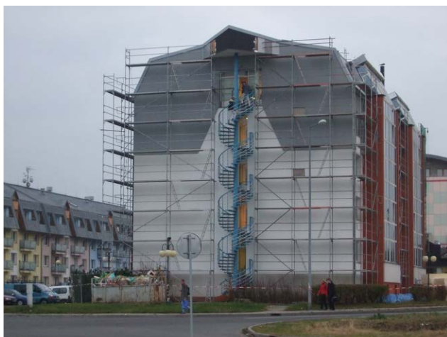
foto /137/ Pohled na předmětný objekt
