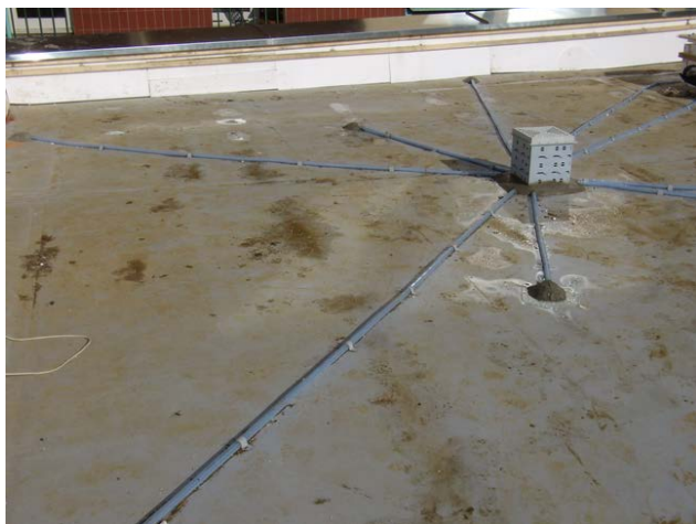
foto /70/ Obetonování kontrolních trubec; osazení šachty pro vyvedení kontrolních trubec
