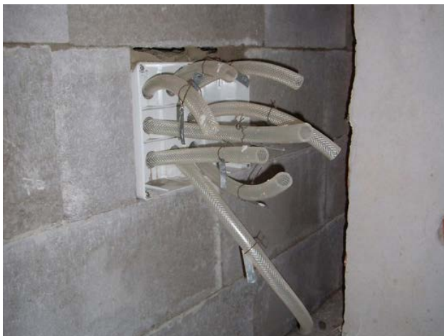
foto /29/ Vyústění kontrolních hadic systému DUALDEK
