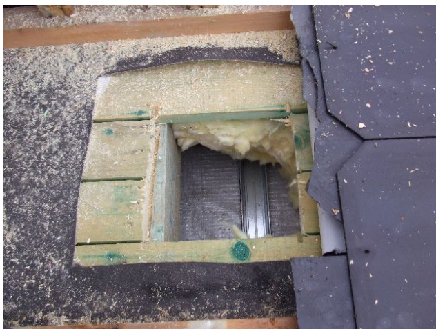
foto /188/ Pohled na sondu s dřevěným bedněním, tepelnou izolací z minerální vlny a parozábranou
