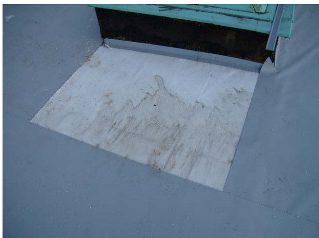
foto /64/ Pokládka první vrstvy PVC-P fólie DEKPLAN 77
