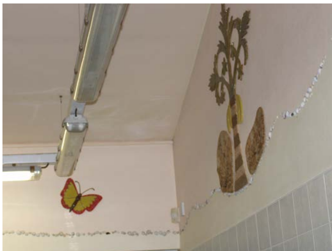
foto /195/ Reálné foto pohledu v interiéru ve vnitřním koutu
