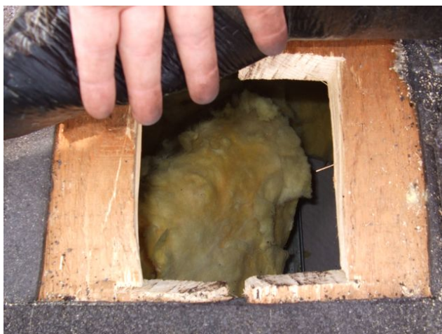
foto /143/ Jedna ze sond provedených do skladby střechy; viditelná tepelná izolace z minerální vlny, bednění z dřevěných prken
