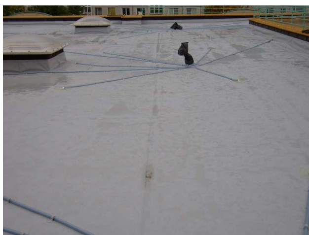
foto /67/ Osazení kontrolních trubíc svedených do jednoho místa
