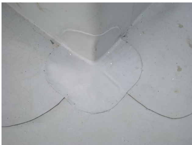
foto /82/ Detail provedení hydroizolace z PVC fólie s rohovou tvarovkou
