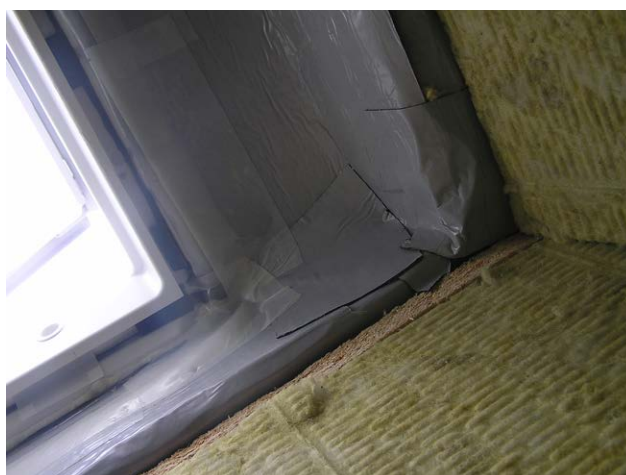
foto /136/ Detail opravy parozábrany okolo střešního okna
