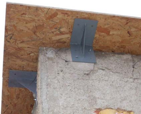
foto /105/ Vynesení OSB desky pomocí úhelníků s výztuhami přes líc atiky kvůli budoucímu zateplení obvodových stěn
