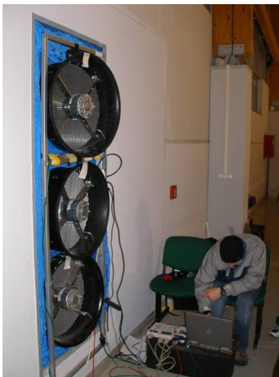
foto /166/ Provádění blower-door testu
