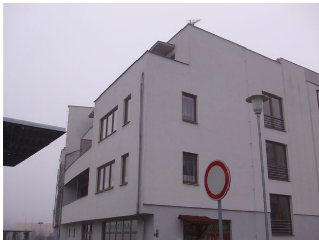
foto /210/ Severovýchodní pohled na objekt
