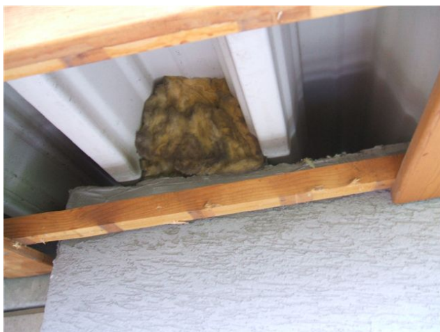
foto /175/ Vlna trapézového plechu vyplněná přířezem minerální vlny
