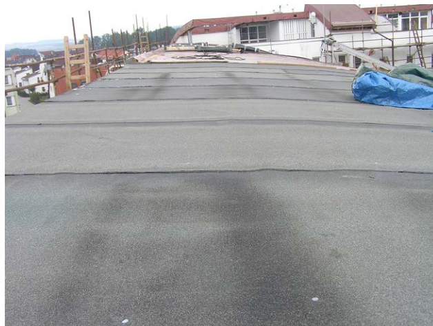
foto /122/ Nová parozábrana z asfaltového pásu GLASTEK 40 SPECIAL MINERAL
