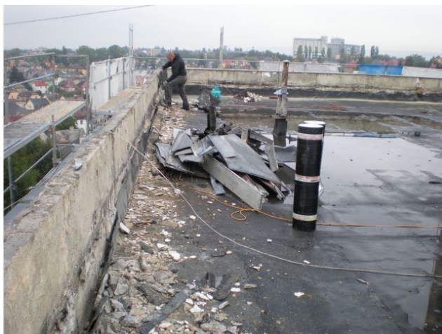
foto /46/ Demontáž původního oplechování a hydroizolace atiky
