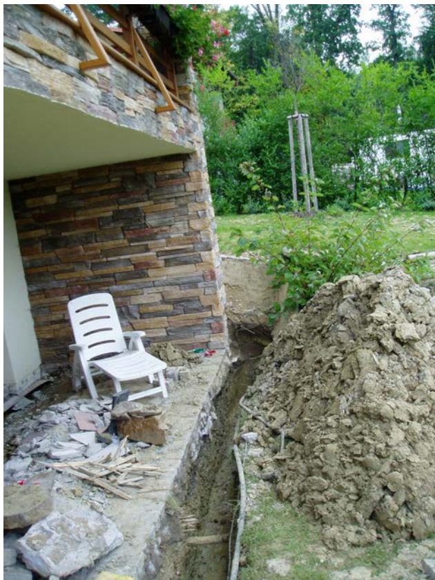
foto /6/ Odkop terénu před terasou
