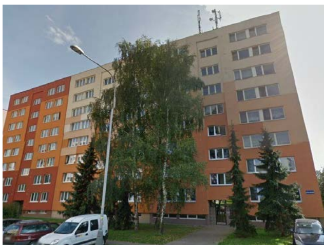
foto /91/ Pohled na předmětný bytový dům
