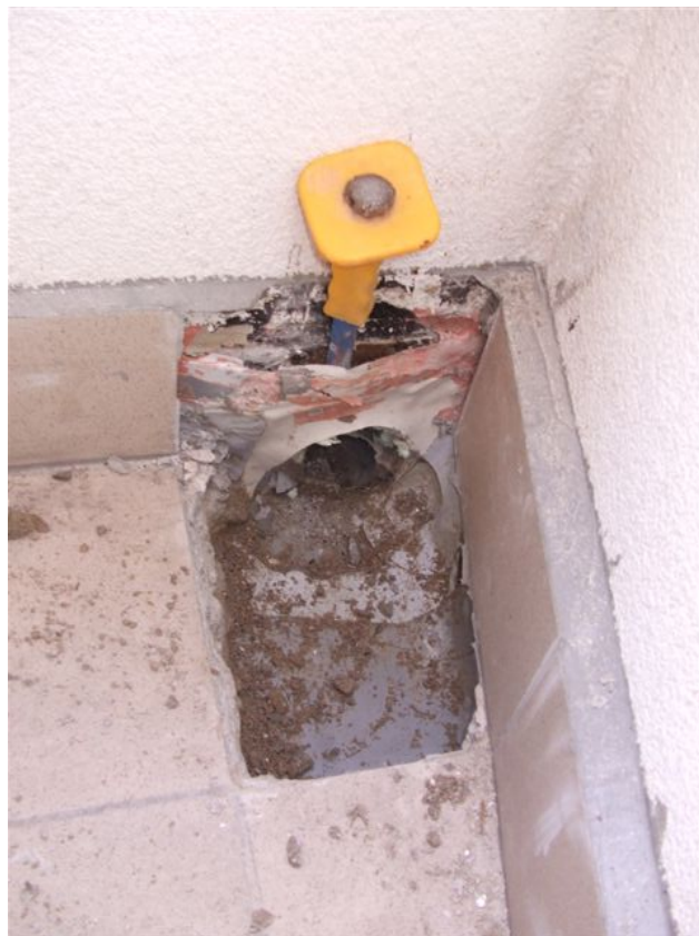
foto /227/ Netěsné napojení tvarovky chříče ke stěně
