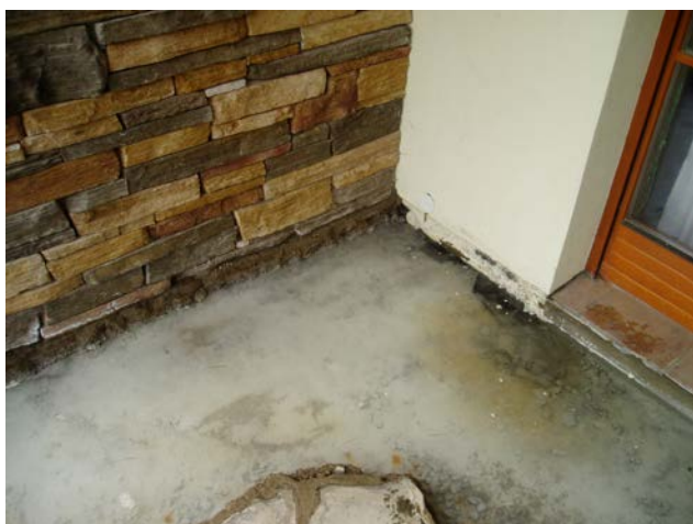
foto /2/ Ustálená hladina vody pod terasou
