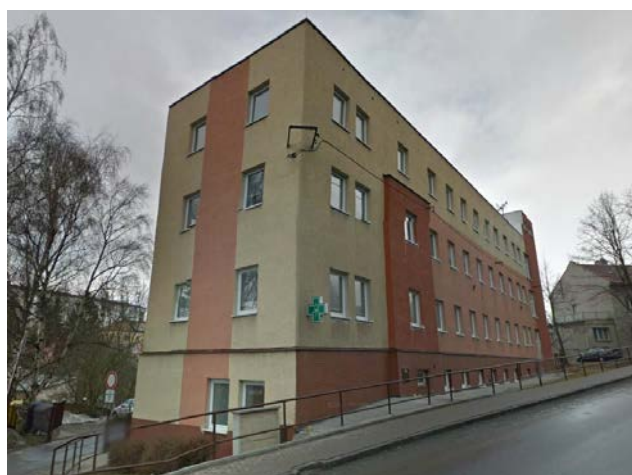
foto /74/ Uliční pohled na předmětný objekt
