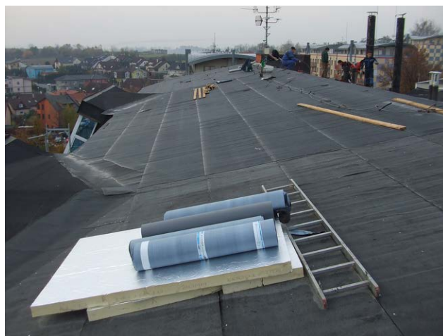
foto /152/ Provedená parozábrana z asfaltového pásu GLASTEK 40 SPECIAL MINERAL; připravená tepelná izolace z PIR DEKPIR TOP 022
