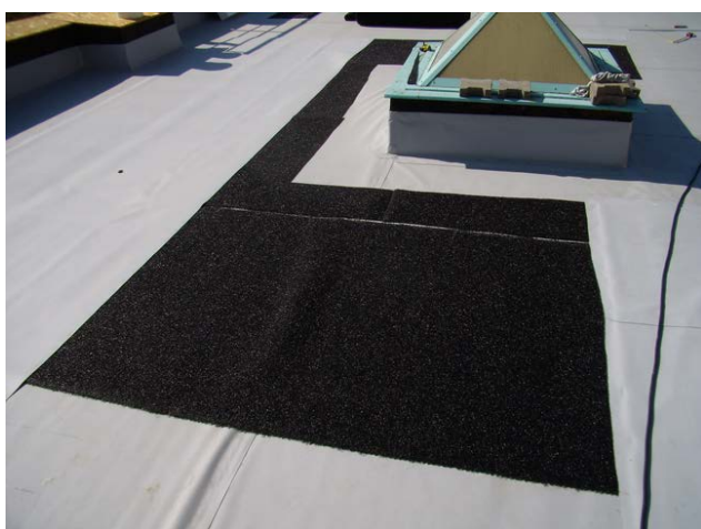
foto /66/ Pokládka drenážní vložky DEKDREN P900 a druhé vrstvy PVC-P fólie DEKPLAN 77 s vytvořením sektorů
