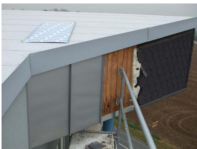
foto /155/ Rozpracovaný detail římsy; pohled na novou hydroizolaci z PVC-P fólie DEKPLAN 76
