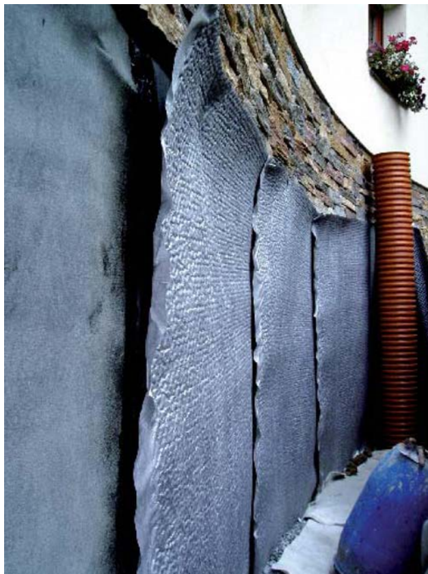
foto /11/ Vertikální plošná drenáž z profilované fólie s nakaširovanou filtrační textilií DEKDREN G8; v rohu revizní plastová šachtice DN 315; proveden zásyp drenážní plastové hadice kamenivem frakce 16/32 a zakrytí filtrační textilií FILTEK 300
