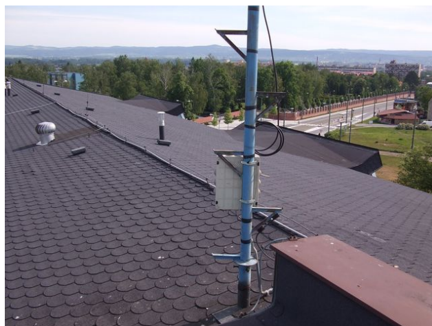
foto /138/ Pohled na část předmětné mansardové střechy
