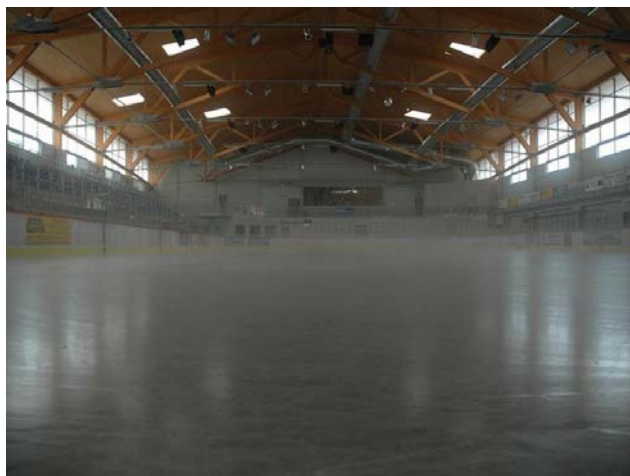
foto /162/ Mlha v interiéru haly
