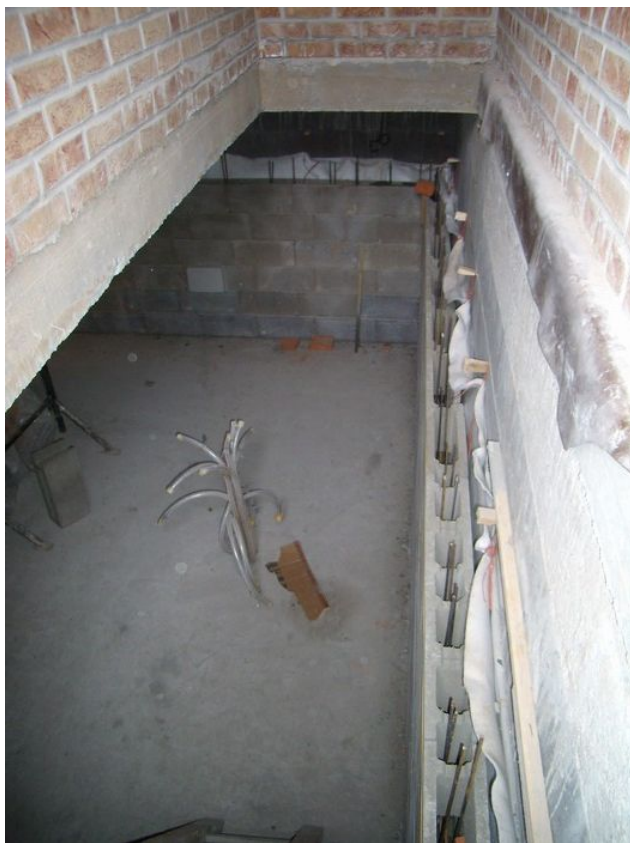
foto /26/ Provádění železobetonové stěny ze ztraceného bednění s vkládanou výztuží
