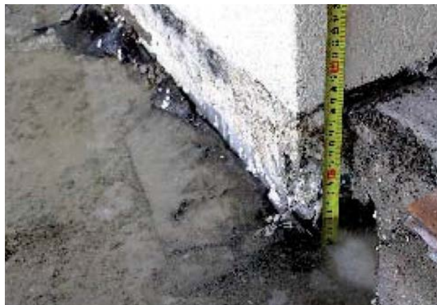
foto /5/ Ustálená hladina vody pod terasou – cca 50 mm
