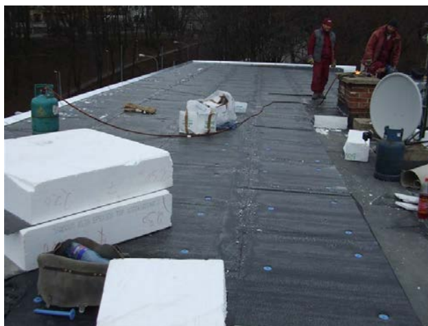
foto /102/ Pohled na střechu s položenými dílci POLYDEK
