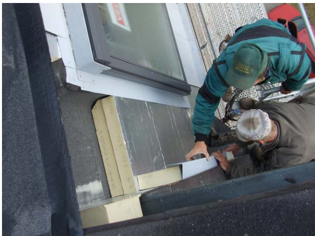
foto /153/ Montáž tepelné izolace z PIR desek
