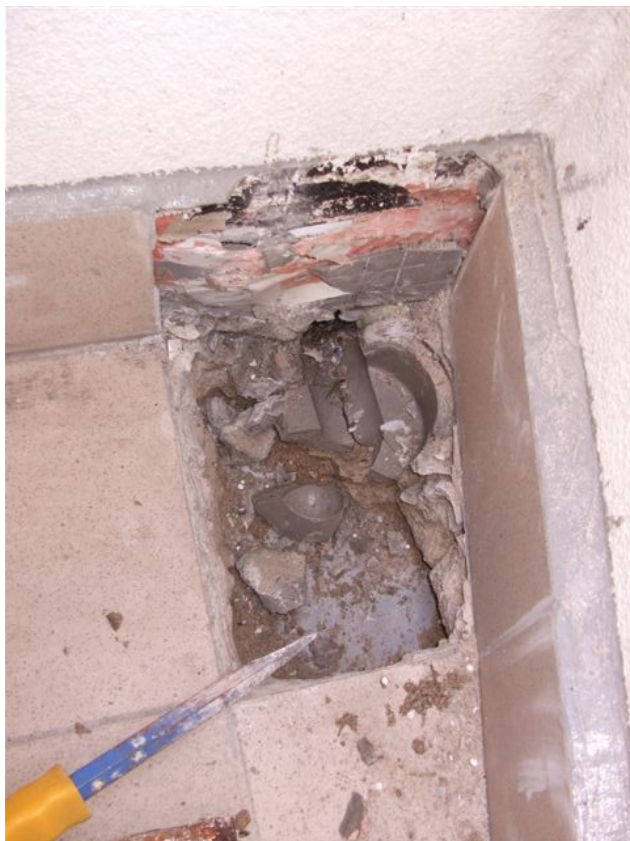
foto /226/ Pohled do sondy po vyjmutí vtoku
