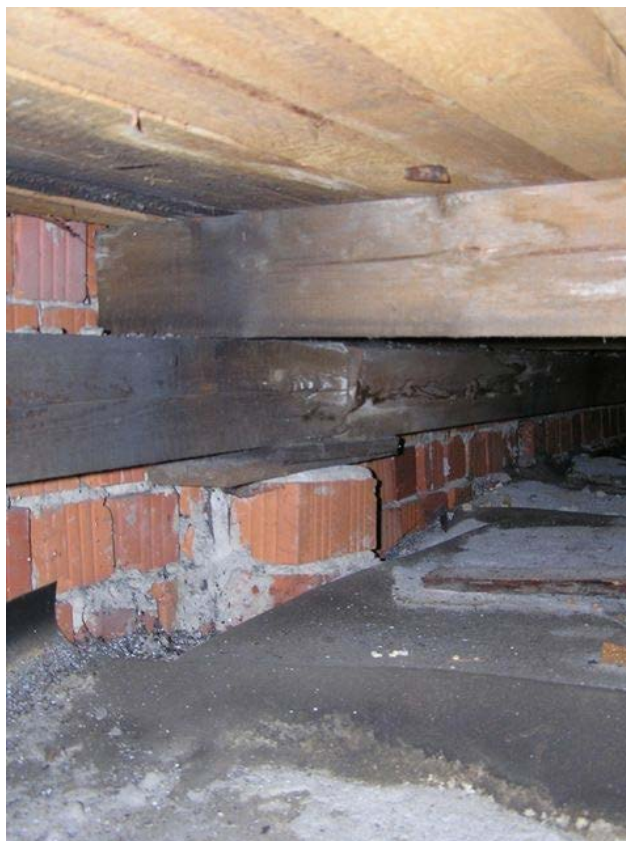
foto /77/ Pohled do větrané vzduchové vrstvy
