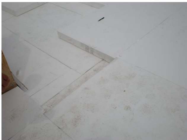
foto /80/ Pokládka tepelné izolace z desek z EPS ve dvou vrstvách
