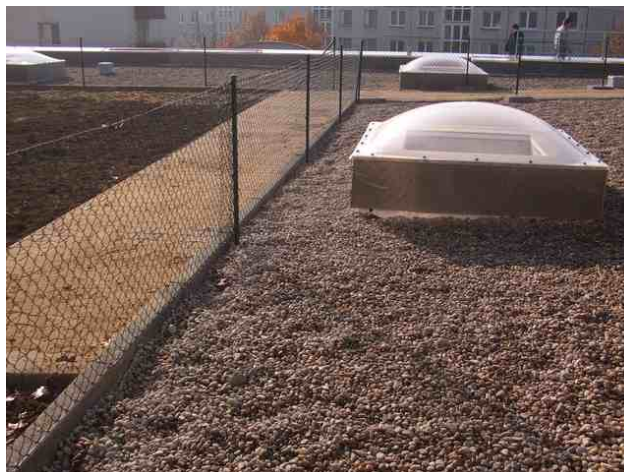
foto /73/ Pohled na finální povrch provozní střechy – pochůzná zámková dlažba na levé straně, vpravo prané říční kamenivo
