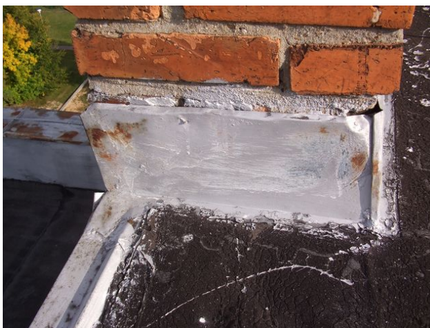
foto /43/ Oplechování větrací šachty
