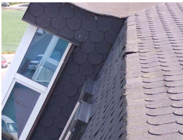
foto /147/ Degradace asfaltových šindelů v místě mansardové hrany
