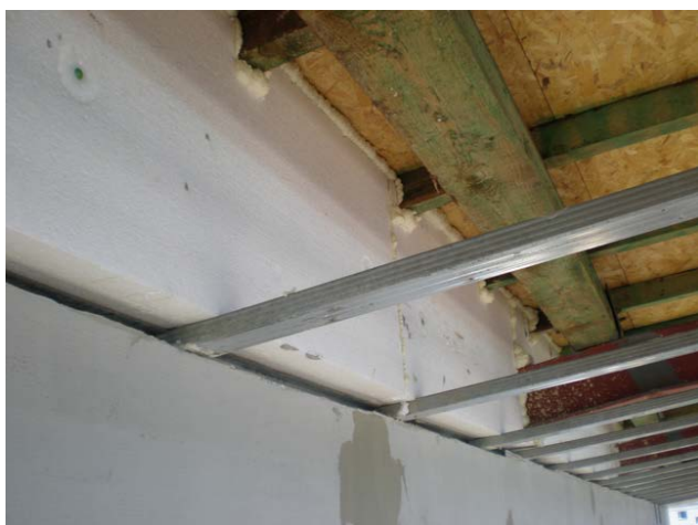
foto /123/ Zateplení a utěsnění původní větrané vrstvy na vnitřní straně stěny
