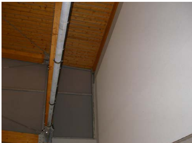
foto /169/ Reálné foto styku boční a štítové stěny se střechou z interiéru
