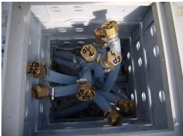
foto /72/ Pohled do krabice pro vyvedení kontrolních trubíc s popisem
