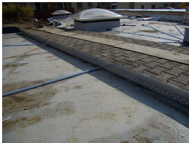
foto /71/ Provádění zámkové dlažby
