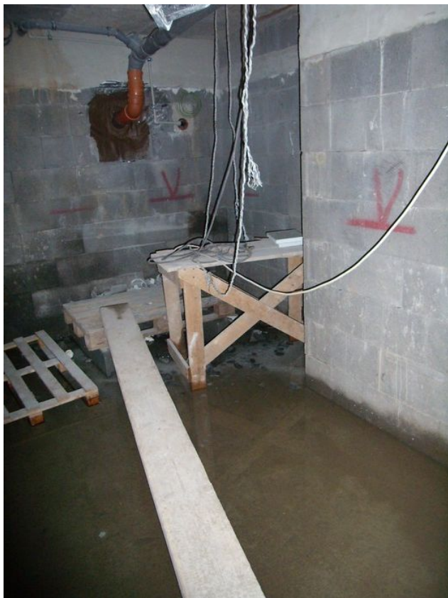
foto /14/ Pohled do suterénu domu před dokončením
