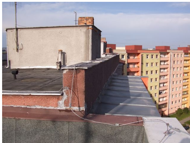
foto /37/ Aplikace tmelu na oplechování atiky
