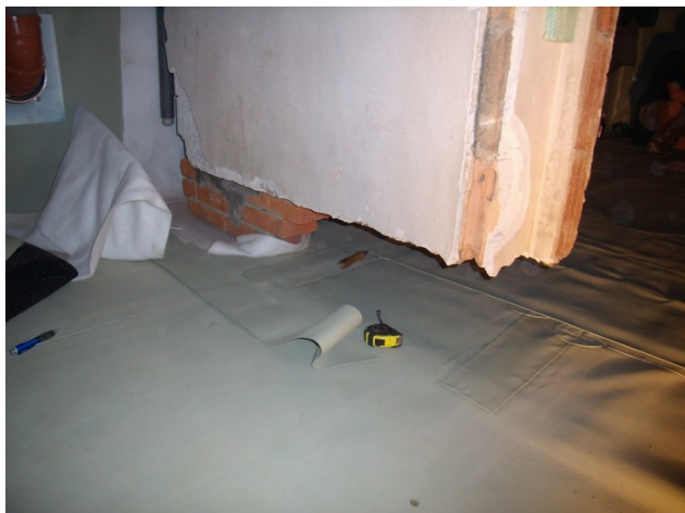
foto /24/ Pracovní vynesení komínové konstrukce
