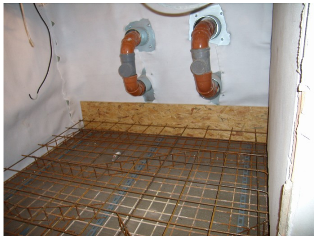
foto /25/ Provádění výztuže železobetonové desky; pevné příruby prostupů; OSB desky jako ochrana svislé části hydroizolace
