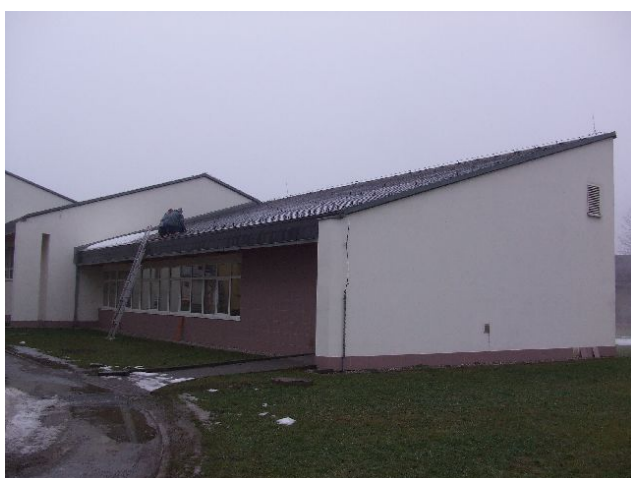
foto /182/ Pohled na objekt z jihovýchodu - bazénová hala
