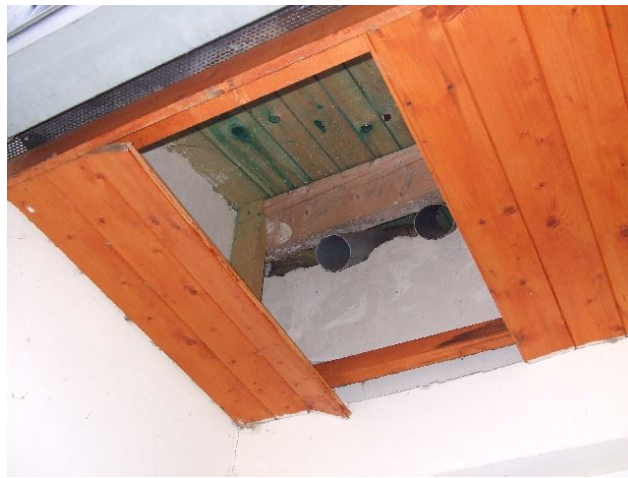
foto /187/ Odkryté podbití s vloženými PVC trubkami
