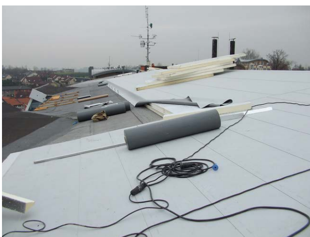
foto /156/ Postupná pokládka tepelné izolace a hydroizolace z PVC-P fólie DEKPLAN 76
