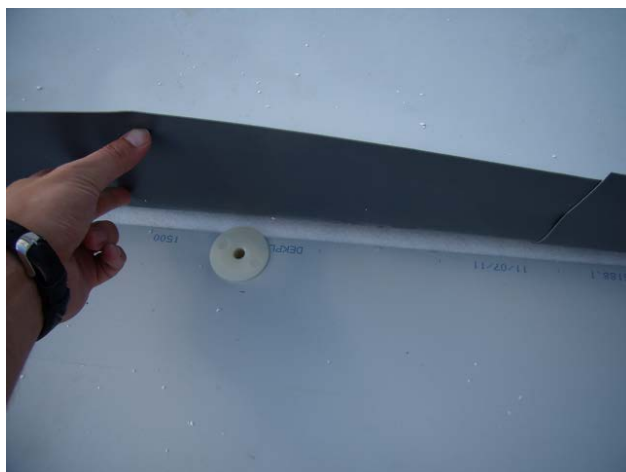
foto /65/ Pokládka první vrstvy PVC-P fólie, montážně kotvené do nosné konstrukce
