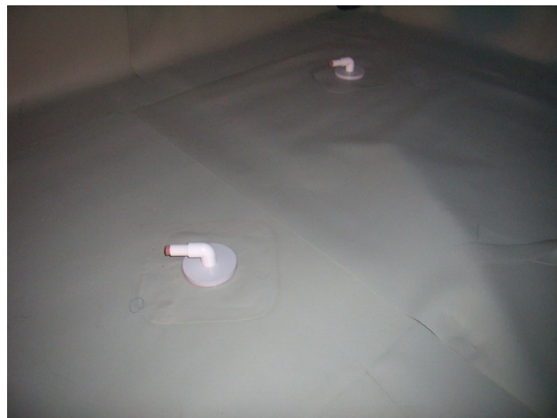
foto /17/ Kontrolní trubice na vodorovné části hydroizolace
