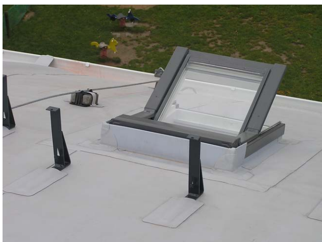
foto /135/ Detail opravy střešního okna z PVC-P fólie
