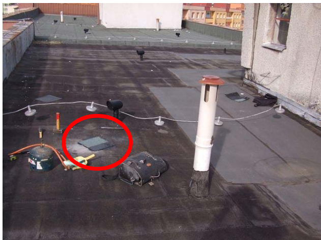
foto /32/ Pohled na místo provedené sondy (zapravena navařením přířezu asfaltového pásu)
