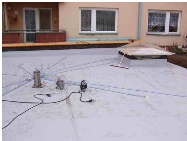
foto /69/ Provádění vakuových zkoušek těsnosti sektorů
