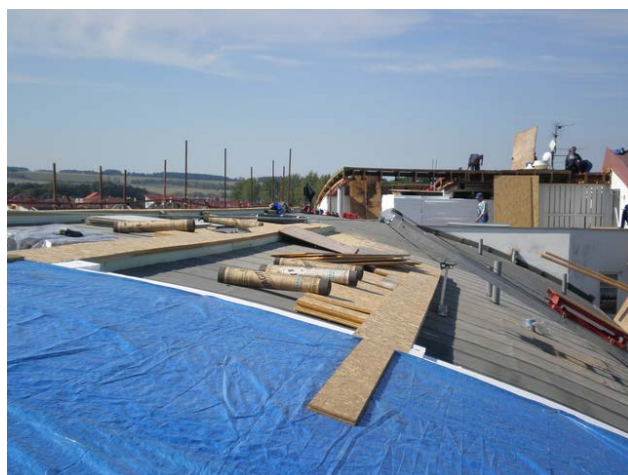
foto /124/ Rozpracovaná oprava střechy – prahy pro kotvení sněhových zachytávačů
