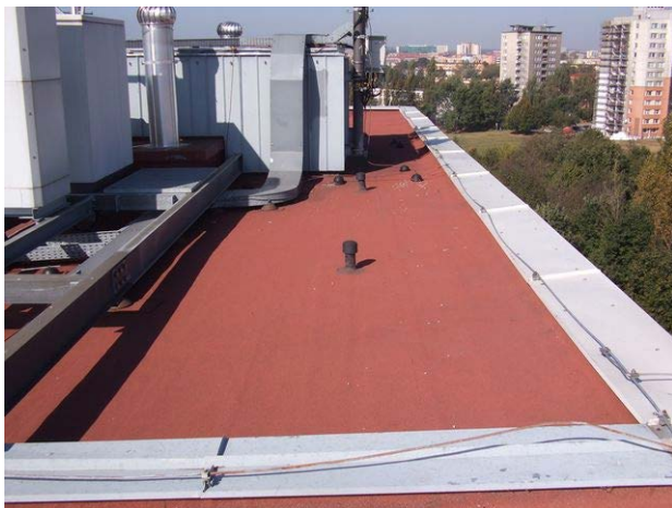
foto /97/ Pohled na předmětnou část střechy
