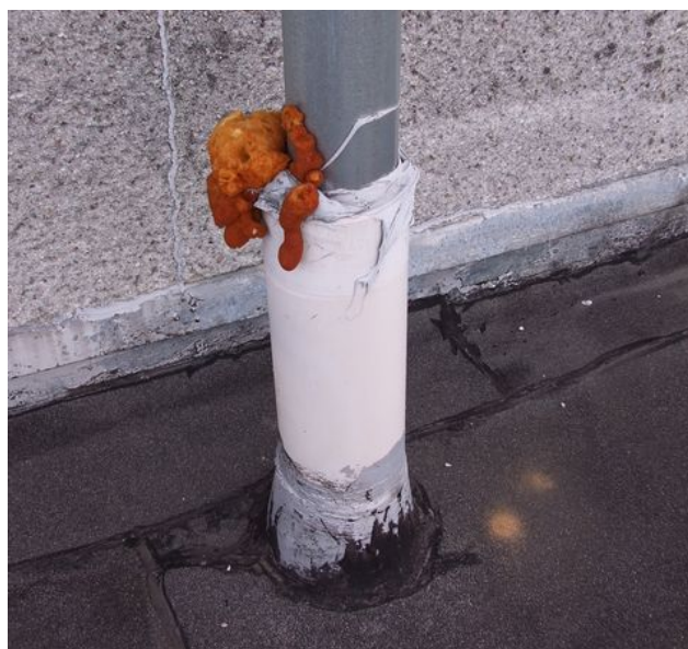
foto /39/ Řešení prostupu pomocí tekutého asfaltu, PUR pěny a tmelu
