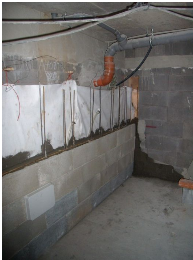
foto /27/ Provádění železobetonové stěny ze ztraceného bednění s vkládanou výztuží
