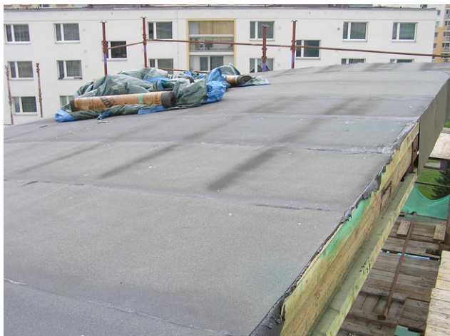
foto /121/ Nová parozábrana z asfaltového pásu GLASTEK 40 SPECIAL MINERAL
