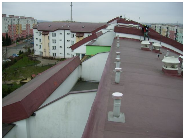
foto /110/ Pohled na střechu objektu
