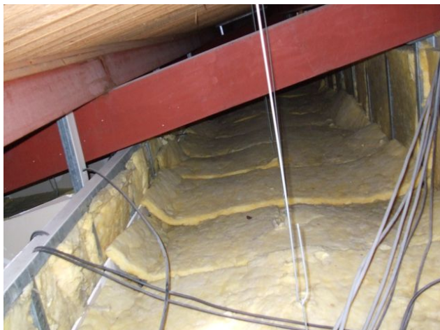
foto /145/ Pohled do vzduchové vrstvy na tepelnou izolaci z minerální vlny
