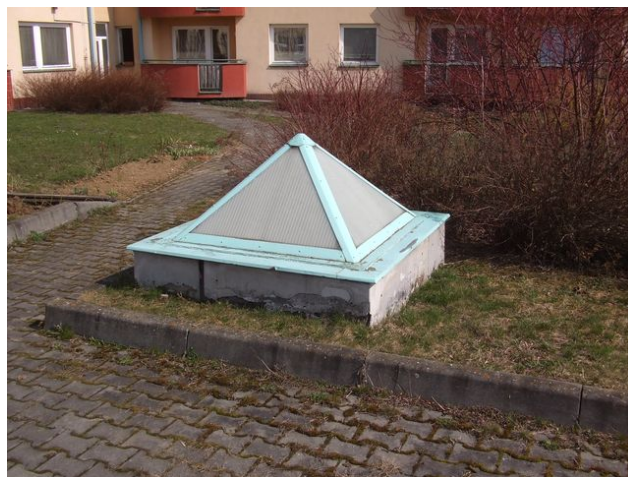
foto /55/ Pohled na vegetační střechu se světlíkem
