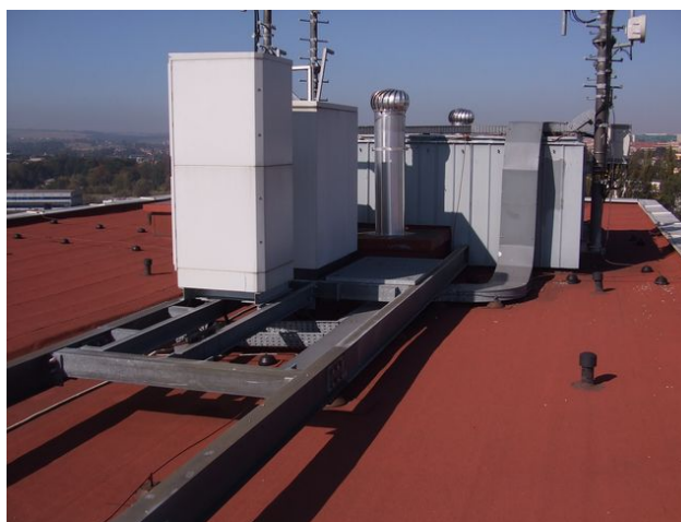
foto /92/ Pohled na střechu předmětného objektu
