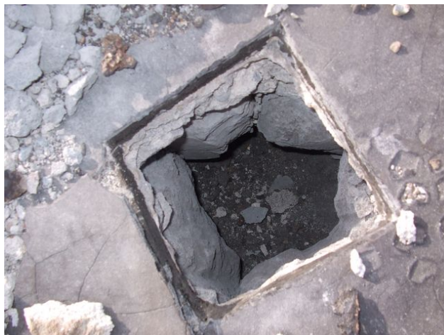
foto /33/ Pohled do provedené sondy
