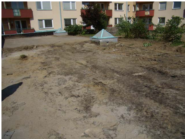
foto /60/ Demontáž vegetační vrstvy
