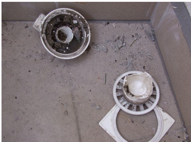
foto /222/ Pohled na demontovanou terasovou vpust'
