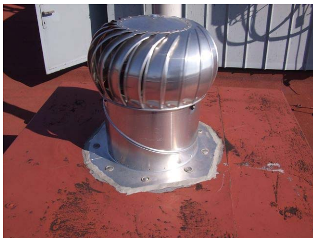
foto /100/ Pohled na nově osazenou ventilační turbínu na ZT komoře
