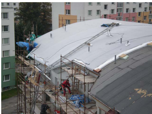
foto /127/ Pohled na rozpracovaný nový hydroizolační povlak z PVC-P fólie DEKPLAN 76 (nahore); dole parozábrana z asfaltového pásu GLASTEK 40 SPECIAL MINERAL
