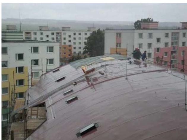
foto /111/ Původní povlaková krytina z PVC-P fólie
