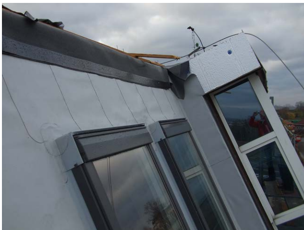
foto /154/ Provedená hydroizolace z PVC-P fólie DEKPLAN 76 kolem střešních oken
