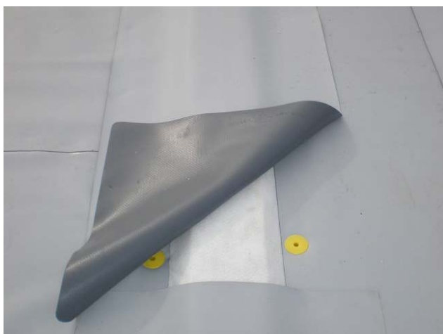
foto /131/ Detail provedení dilatace
