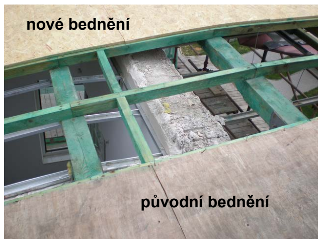
foto /119/ Postupná demontáž hydroizolace a bednění, provádění nového bednění
