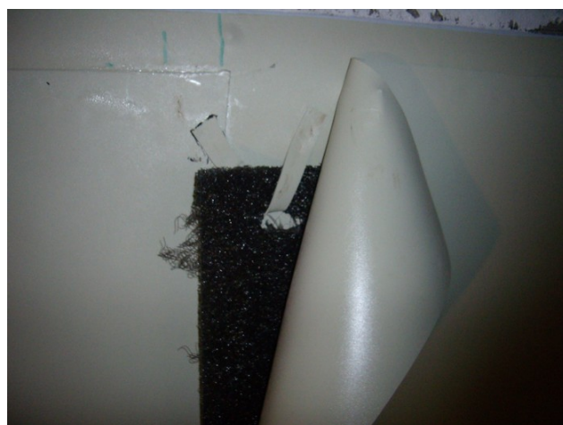
foto /19/ Pohled na rozpracovanou část sektoru s vrstvami hydroizolační fólie Alkorplan a drenážní rohoží DEKDREN P900
