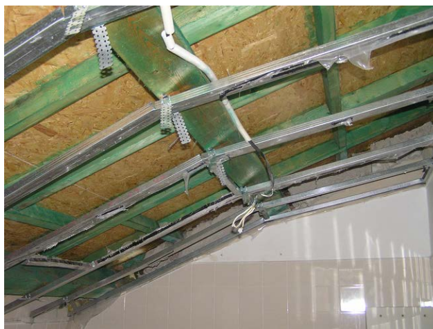
foto /120/ Pohled z interiéru: ponechaný původní nosný rošt sádkartonového podhledu; nový záklop z OSB desek
