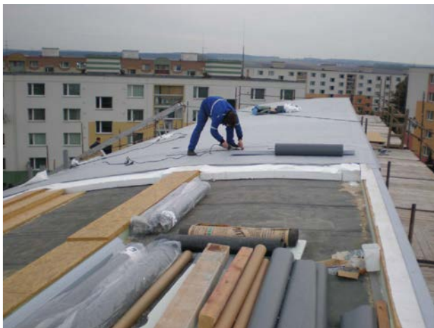
foto /126/ Pohled na rozpracovaný nový hydroizolační povlak z PVC-P fólie DEKPLAN 76 (nahore); dole parozábrana z asfaltového pásu GLASTEK 40 SPECIAL MINERAL
