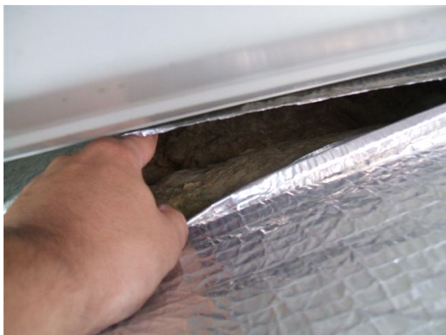
foto /179/ Neslepený přesah horní parotěsnicí fólie
