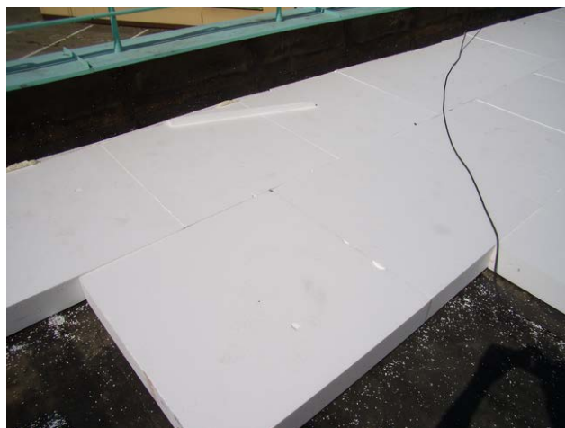
foto /63/ Pokládka spádových tepelněizolačních dílců z pěnového polystyrenu EPS 100S k podkladu lepeny PUK lepidlem
