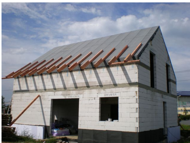
Obr. 78 - Provádění střechy se skladbou TOPDEK pro pasivní domy - montáž námětků
