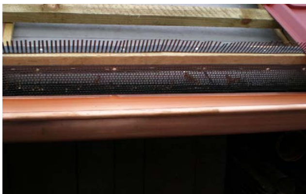
Obr. 27 - Větrací vrstva – napojení u okapu
