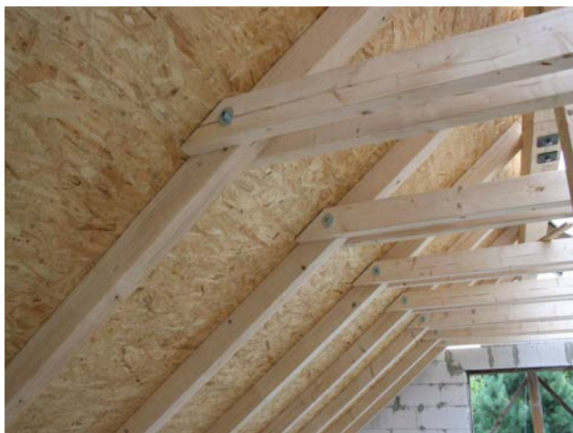
Obr. 72 - Příklad krovu se záklopem z OSB desek
