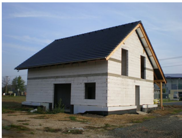
Obr. 81 - Hotová střecha se skladbou TOPDEK pro pasivní domy
