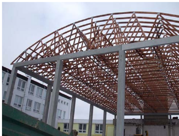
Obr. 73 - Příklad dřevěných příhradových vazníků s horní pásnicí ve tvaru oblouku
