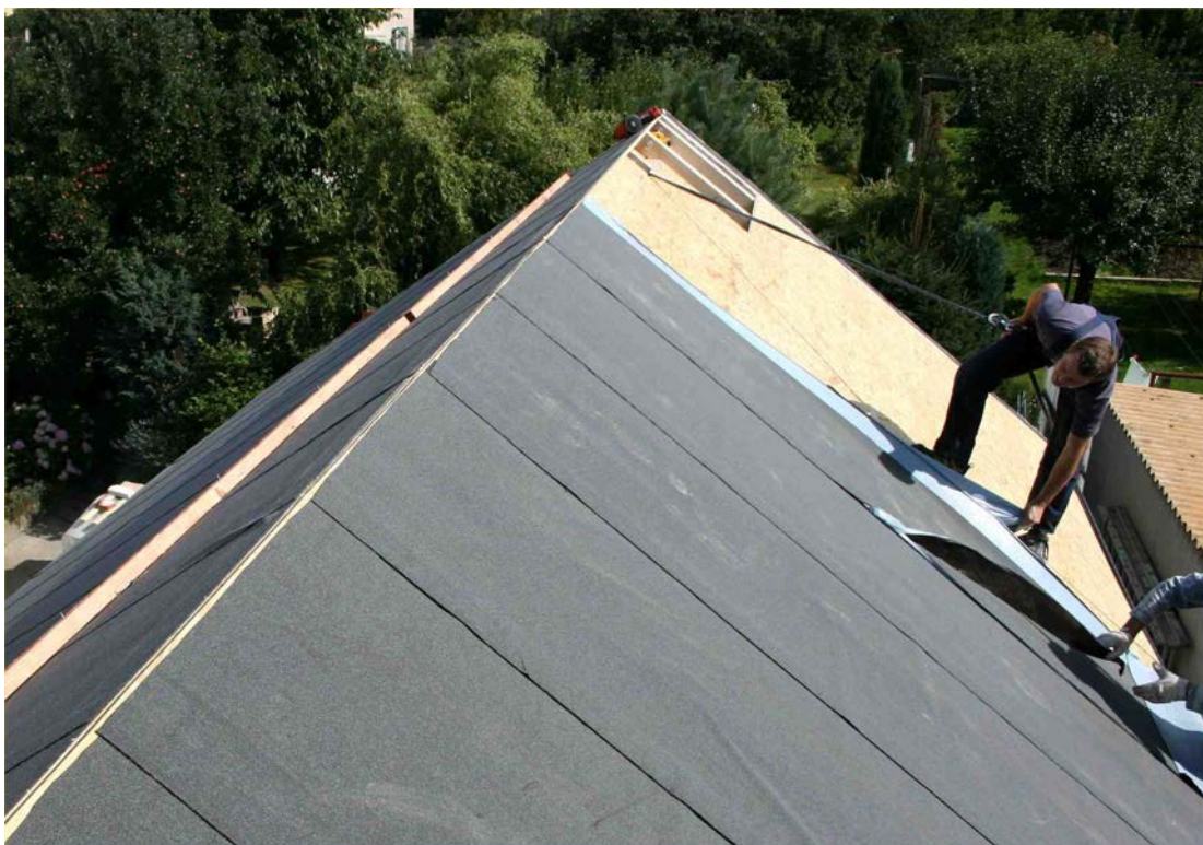
Obr. 69 - Pokládka parotěsnicí a vzduchotěsnicí vrstvy ze samolepícího asfaltového pásu
