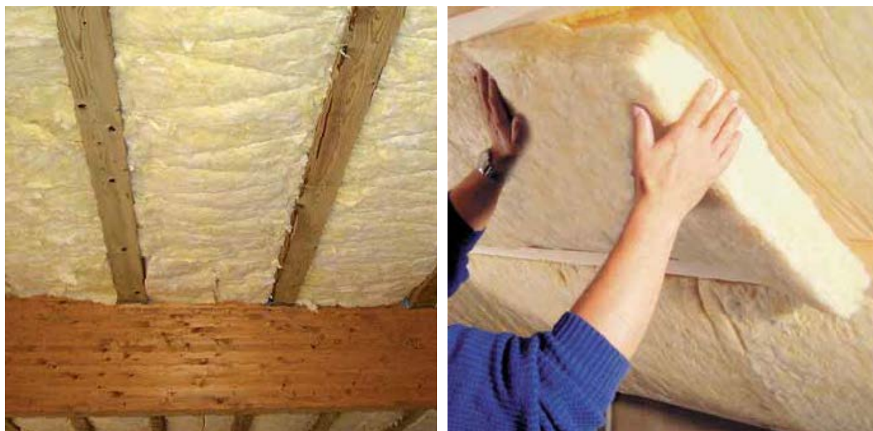
Obr. 54, 55 - Příklad tepelné izolace z minerálních vláken DEKWOOL
