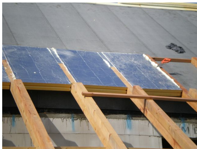
Obr. 79 - Provádění střechy se skladbou TOPDEK pro pasivní domy - montáž tepelné izolace z PIR desek
