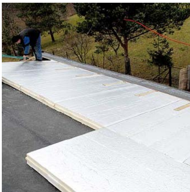
Obr. 57 - Desky z polyisokyanurátu se sendvičovou fólií z papírové vložky a hliníkové vrstvy
