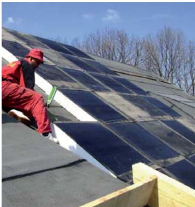
Obr. 56 - Desky z EPS s nakaširovaným asfaltovým pásem POLYDEK
