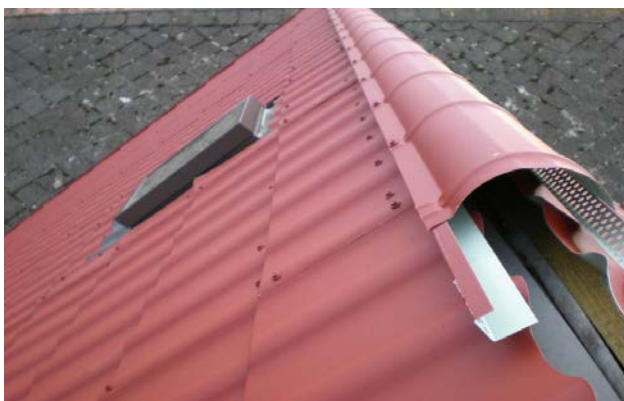
Obr. 28 - Větrací vrstva – napojení u hřebene
