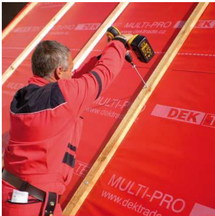
Obr. 44 - Montáž kontratát na fólii DEKTEN MULTI-PRO
