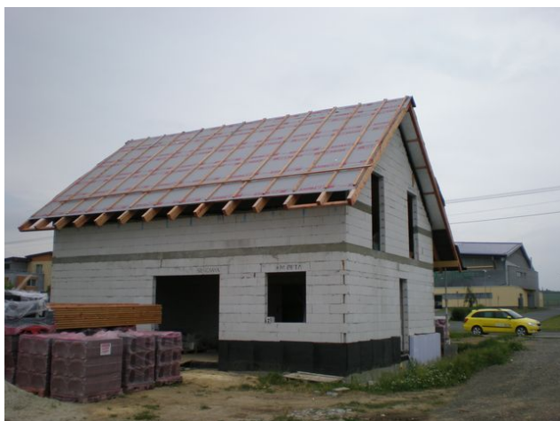
Obr. 80 - Provádění střechy se skladbou TOPDEK pro pasivní domy - položena doplňková hydroizolační vrstva a kontralatě
