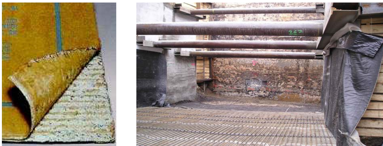
Obr. 30 – Provádění vodotěsné konstrukce s bentonitem
