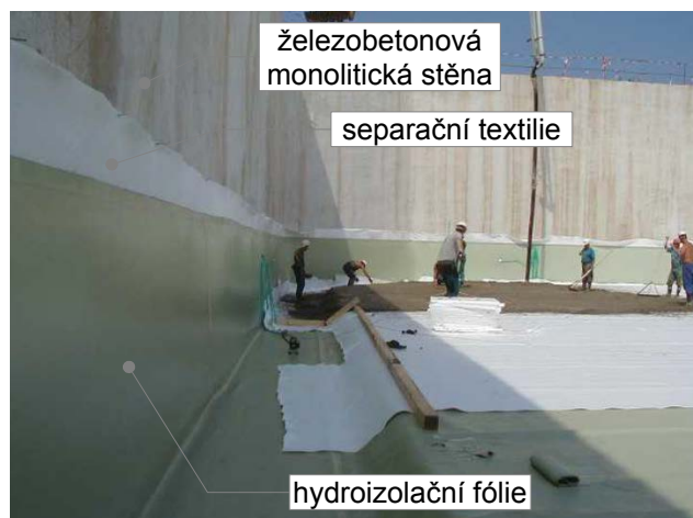
Obr. 18 – Provádění hydroizolace spodní stavby z plastové fólie
