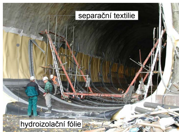
Obr. 19 – Provádění hydroizolace z plastové fólie - inženýrské stavby - dálniční tunel
