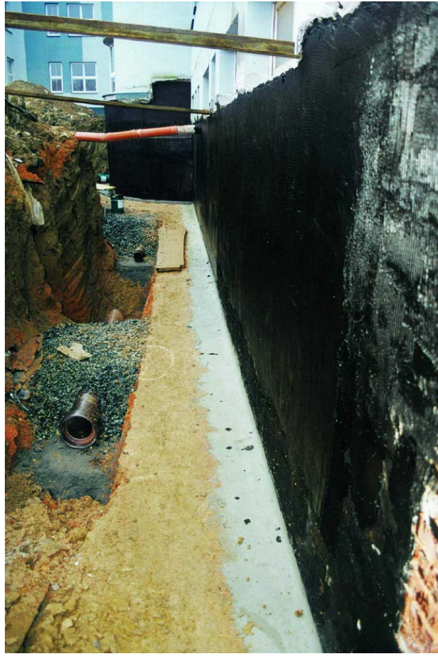
Obr. 29 – Provádění hydroizolační stěrky
