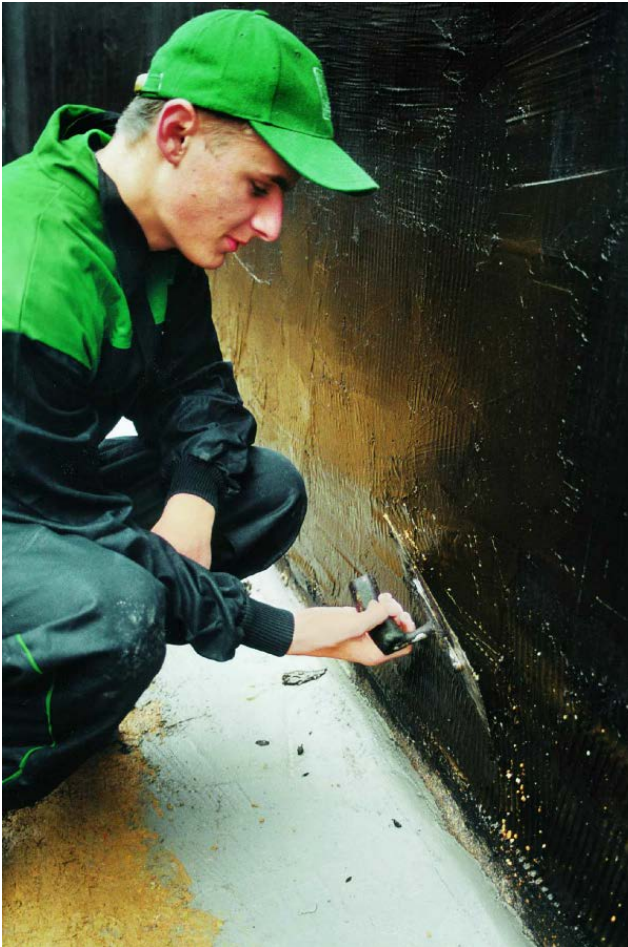
Obr. 28 – Provádění hydroizolační stěrky
