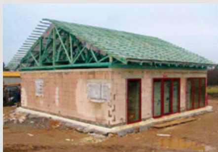
Stavba z předchozího obrázku s namontovanými střešními vaznicemi (obě foto: Kalksandstein CZ s.r.o.)
