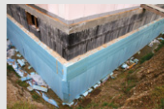
Hydroizolační asfaltové pásy – svislá část hydroizolace pod tepelnou izolací základů (ENVIC, o.s.)
