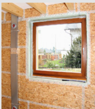
Parobrzd a zároveň vzduchotěsnící vrstva z OSB desek na interiérové straně stěn dřevostavby. (ENVIC, o.s.)
