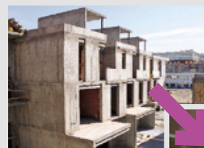
Železobetonová konstrukce (Filip Šlapal)
