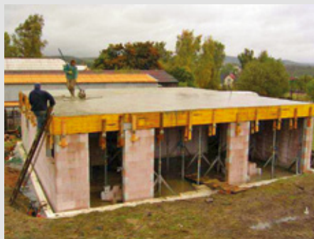
Masivní železobetonový monolitický strop – z vrchní strany bude doplněn tepelnou izolací, nad stropem bude lehké zastřešení na vaznicích
