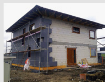
Masivní obvodová stěna z vápenopískových cihel, tepelná izolace z polystyrenu celoplošně lepeného (Kalksandstein CZ s.r.o.)
