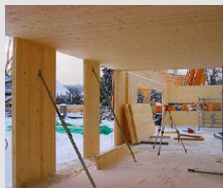
Masivní dřevěný strop – z vrchní strany bude doplněn tepelnou izolací (Abete dřevostavby)
