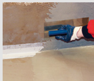
Aplikace hydroizolační stěrky (SOUDAL)
