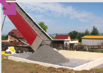
Drť z pěnoskla pod základovou deskou (Kalksand- stein CZ, s.r.o.)
