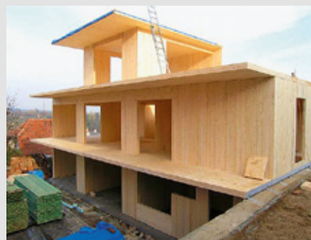
Nosná konstrukce z dřevěných panelů – bude doplněna vnější tepelnou izolací (Abete dřevostavby s.r.o.)
