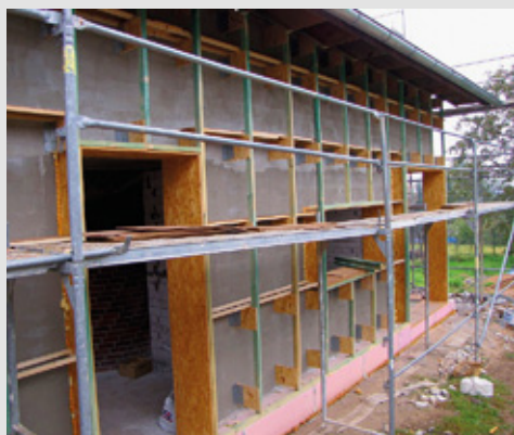
Příprava fasádního pláště (rošt bude zakryt dřevovláknitými deskami) pro foukanou drčenou celulózu (AB Atelier)
