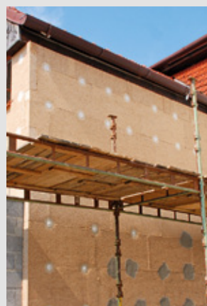
Masivní obvodová stěna z cihel, tepelná izolace z konopí (Canabest, s.r.o.)
