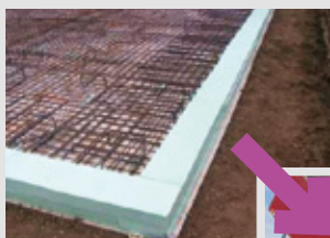
Extrudovaný polystyren pod základovou deskou (Setrite, s.r.o.)
