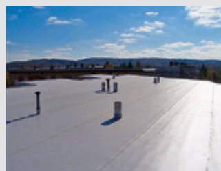
Plochá střecha s povlakovou fóliovou hydroizolací (Izoltecz)
