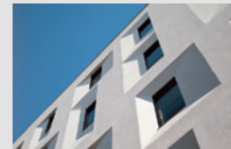
Architektonicky zajímavá úprava ostění pro zlepšení prosvětlenosti interiéru. (materiál databanky STO)
