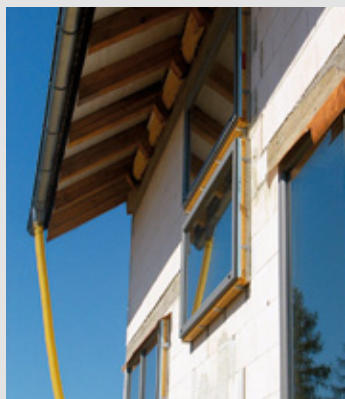
Předsazená montáž oken (Kalksandstein CZ s.r.o.)
