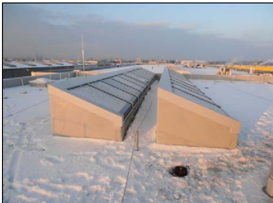
Obr. /23/ - Pohled na střešní světlíky
