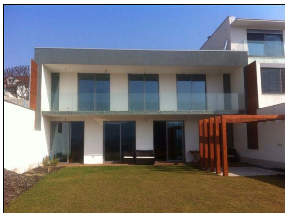
Obr. /8/ - Pohled na fasádu rodinného domu
