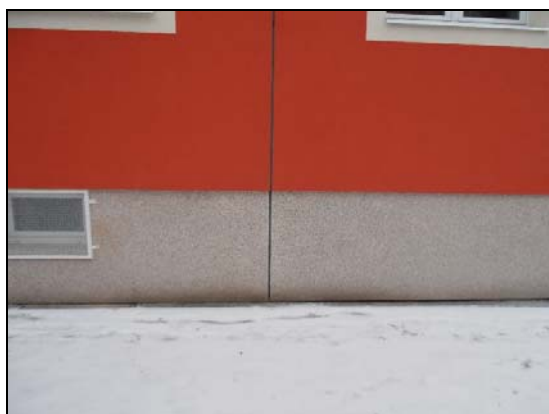
Obr. /19/ - Pohled na fasádu domu v oblasti soklu
