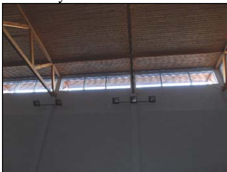
Obr. /33/ - Pohled na napojení stěny a střešy sportovní haly
