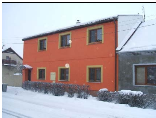
Obr. /15/ - Fotografie fasády RD
