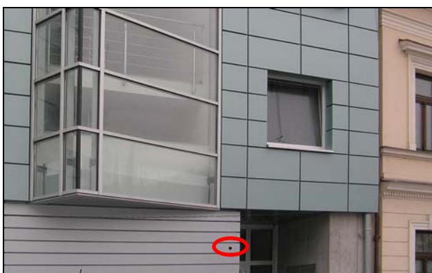
Obr. /42/ - Fotografie části fasády
