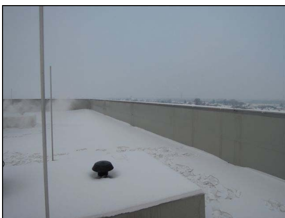
Obr. /25/ - Pohled na atiku střechy
