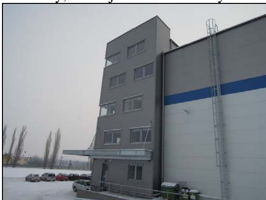
Obr. /31/ - Pohled na část fasády admin. objektu
