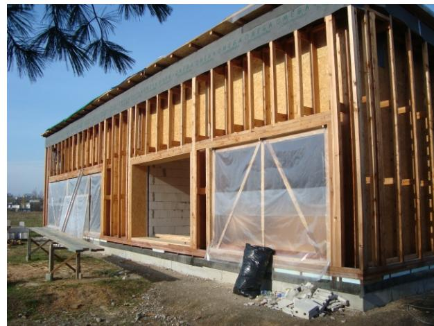
**Foto:** Příklad sloupkové dřevostavby. Použity jsou žebříkové nosníky, které neprochází skrze celou konstrukci, a tudíž nevytváří tepelné mosty. (foto Knauf Insulation)
