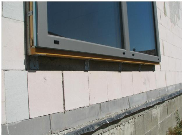
**Foto:** Předsazená montáž okna do vrstvy izolace v masivní stavbě. Snižuje se tím tepelný most osazení. (foto Kalksandstein)
