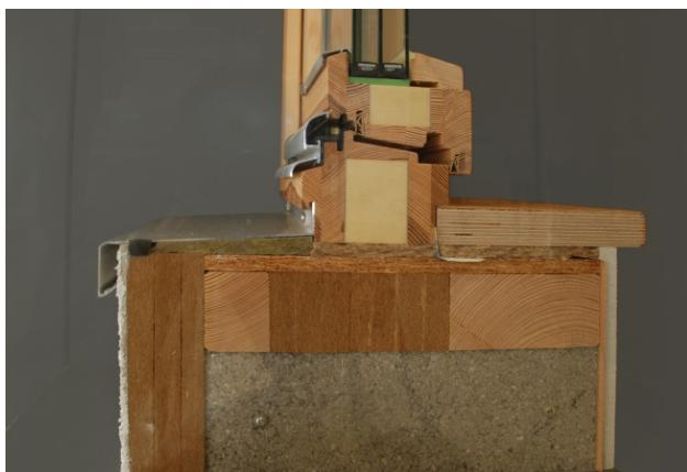
**Foto:** Příklad osazení okna do stěny dřevostavby v místě parapetu. Jak je vidět, okno je vyloženo co nejvíce do exteriéru v kastlíku z OSB desek, aby se snížilo na minimum stínění ostěním.
