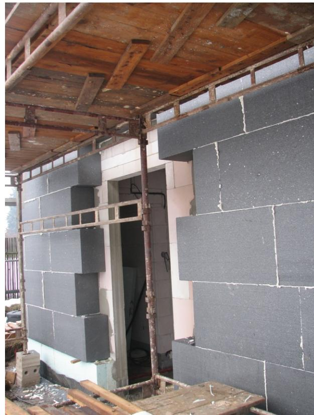
**Foto:** Pro využití dobrých vlastností masivních staveb je vhodnou volbou subtilní a těžká nosná konstrukce s vnějším zateplením dostatečnou vrstvou izolace. (foto Kalksandstein)
