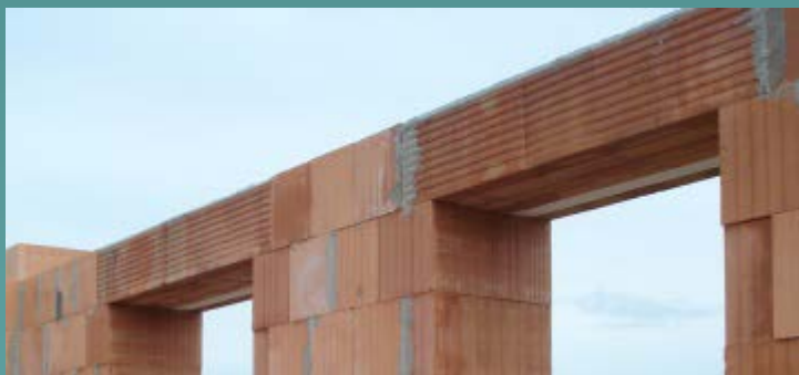
Uložení překladu porotherm 7
